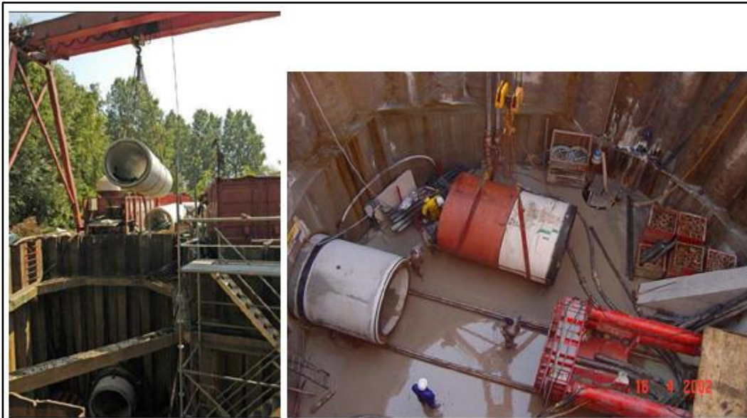
Figura 3-15 Installazione dei conci in calcestruzzo armato
