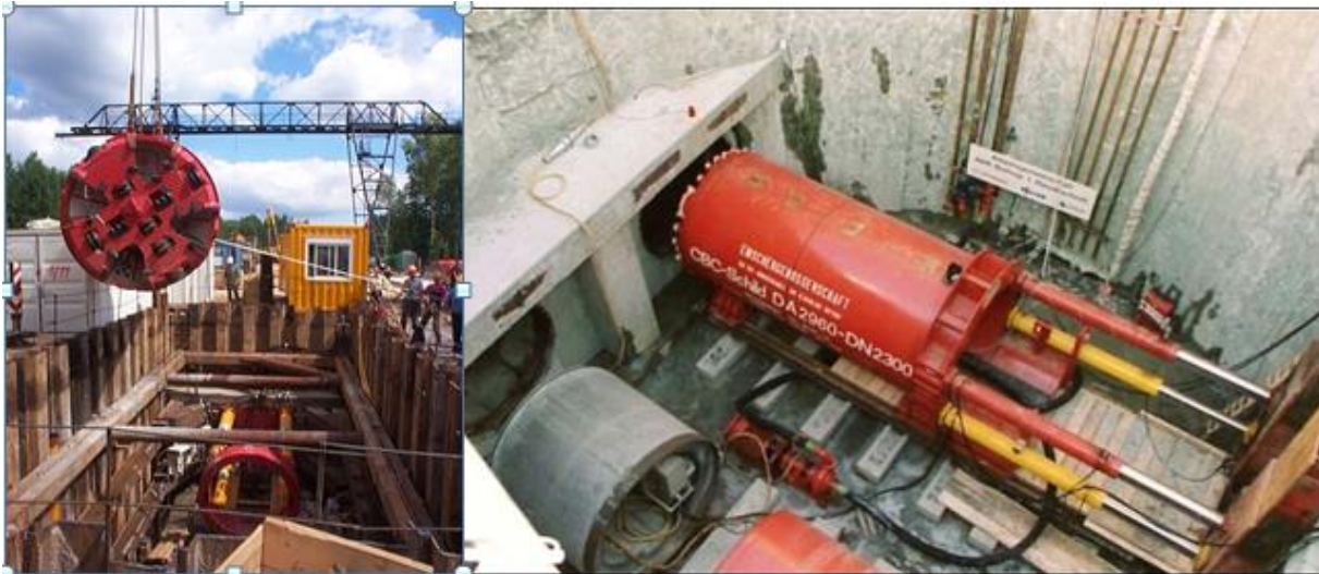
Figura 3-11 Installazione dello scudo fresante (TBM)
