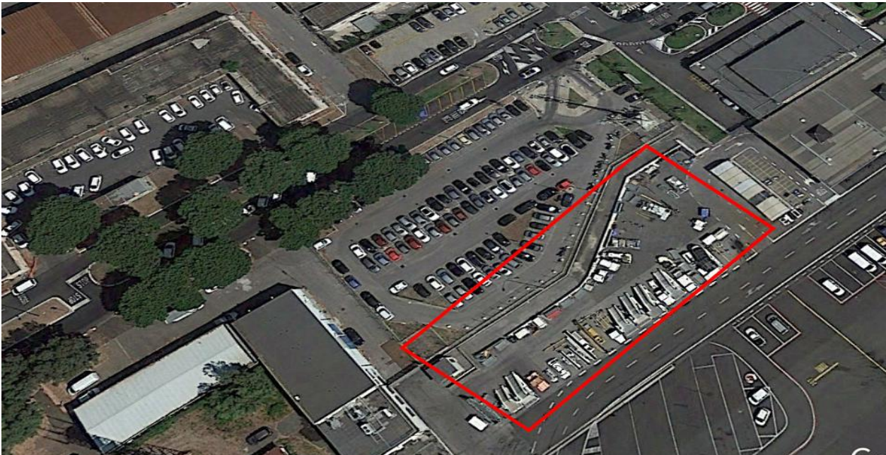
Figura F7– Foto area del 17/7/2015 tratta da Google Earth - LAVORI COSTRUZIONE A LATO AEROSTAZIONE AVIAZIONE GENERALE (ante) con evidenziazione area della futura costruzione
