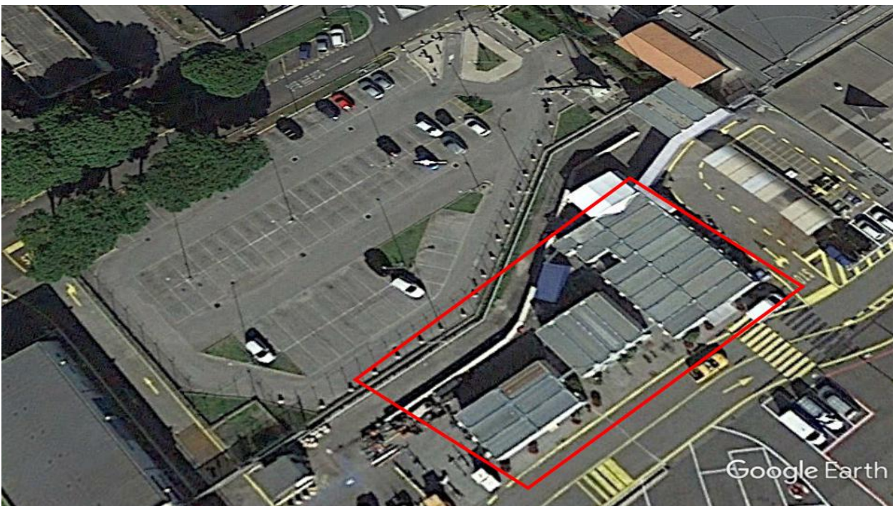
Figura F8 – Foto area del 29/10/2016 tratta da Google Earth - LAVORI COSTRUZIONE A LATO AEROSTAZIONE AVIAZIONE GENERALE con evidenziazione area della nuova costruzione realizzata
