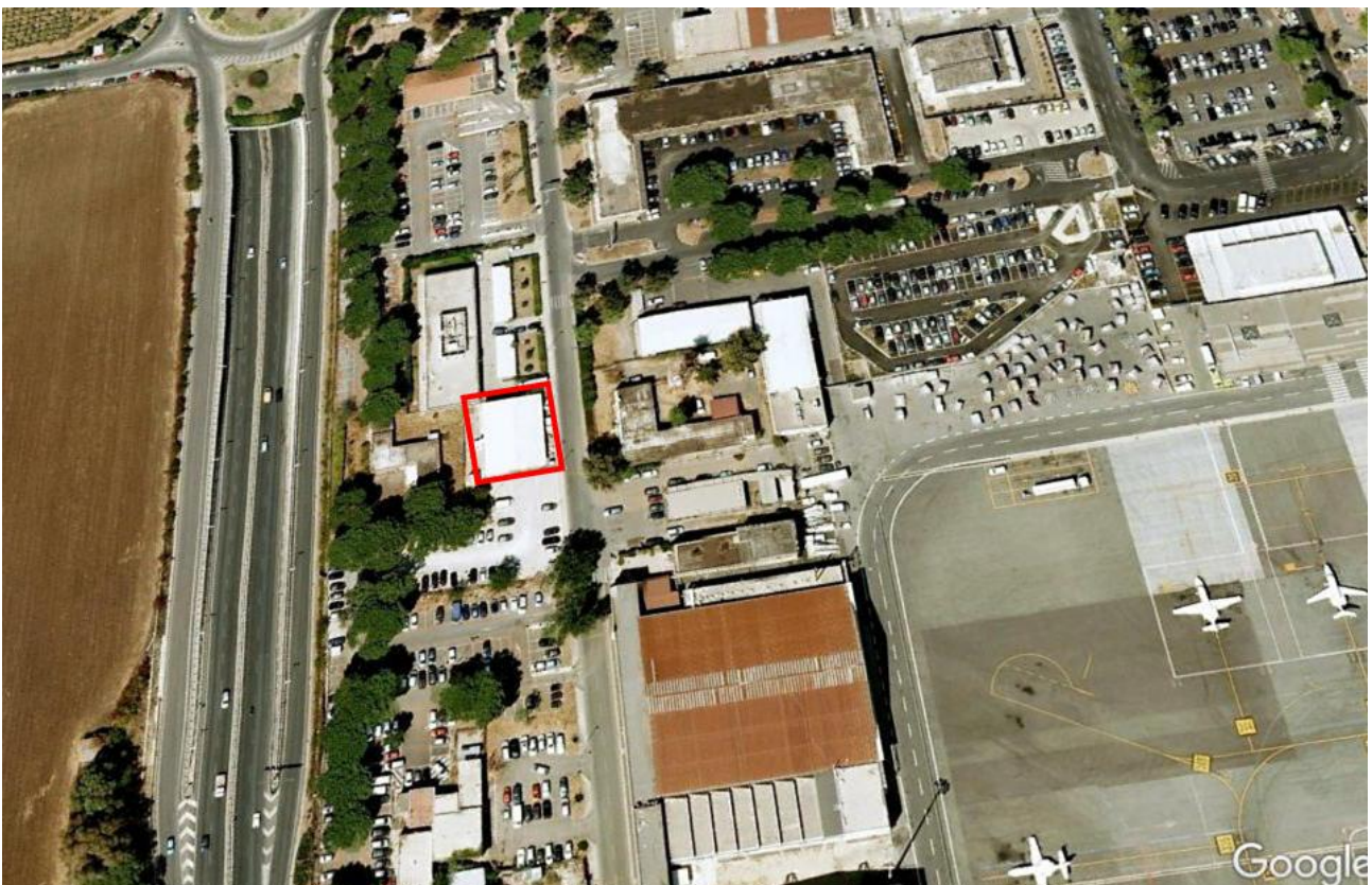
Figura F6 – Foto area del 29/7/2007 tratta da Google Earth - LAVORI COSTRUZIONE LATO AVIAZIONE GENERALE (post) - con evidenziazione area della nuova costruzione realizzata
