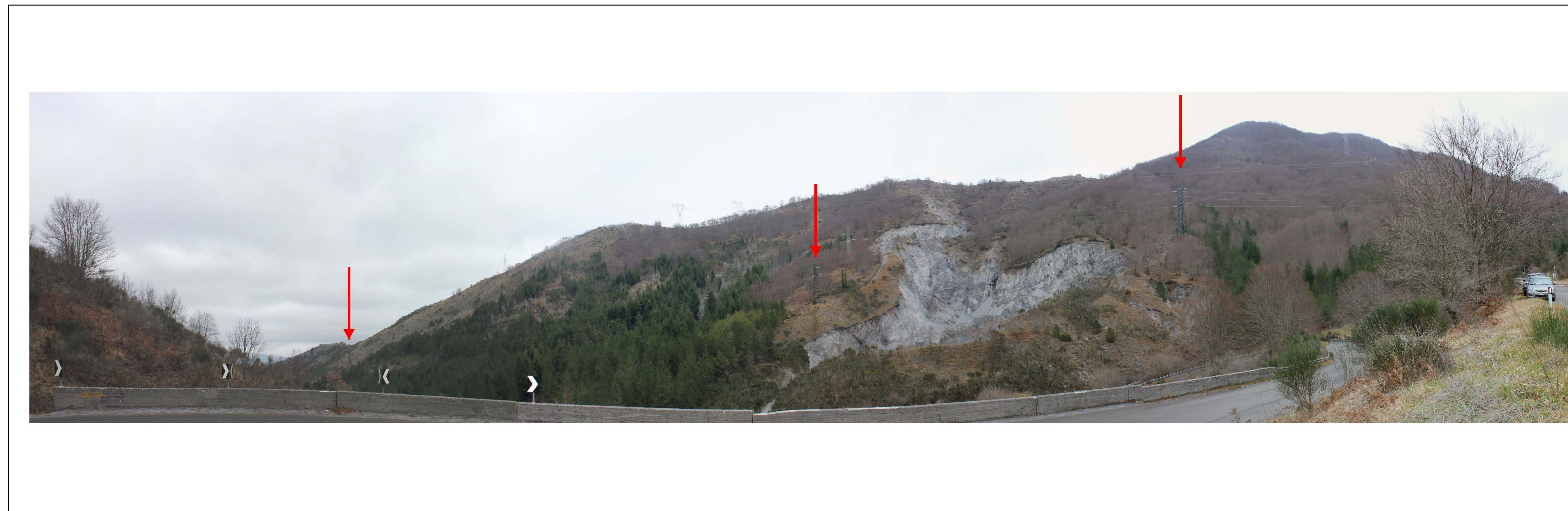
Stato di fatto (→ Demolizioni)
