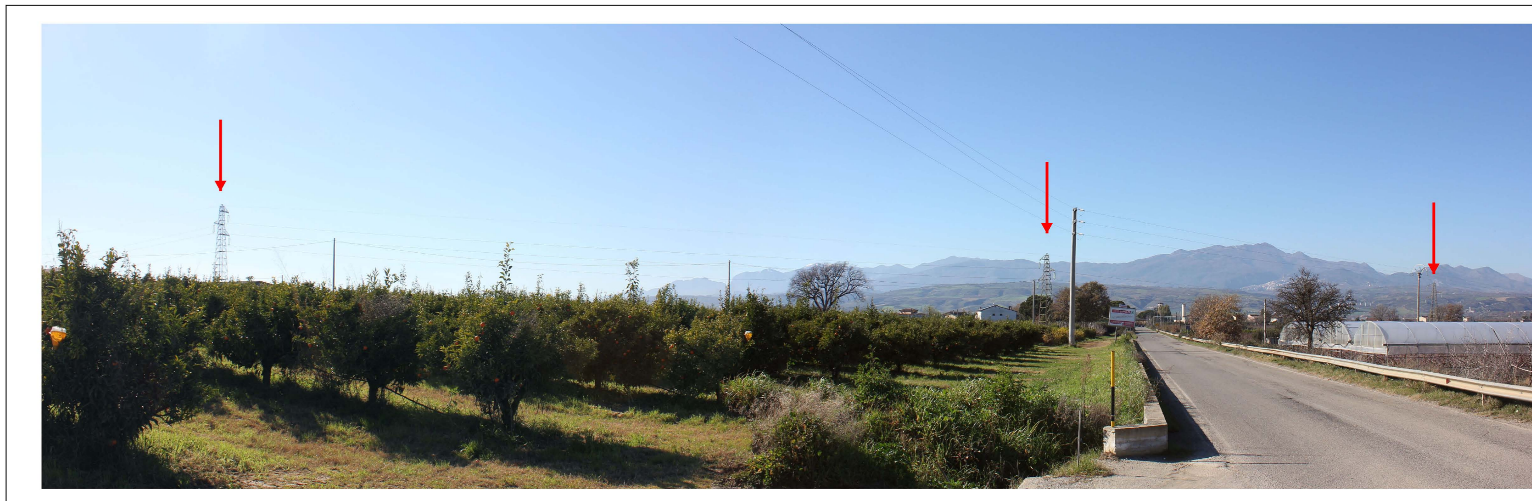
Stato di fatto (→ Demolizioni)
