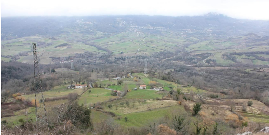
Figura 6-5 Vista delle linee Laino – Rossano (Terna 322) e Laino – Rossano (Terna 346)
