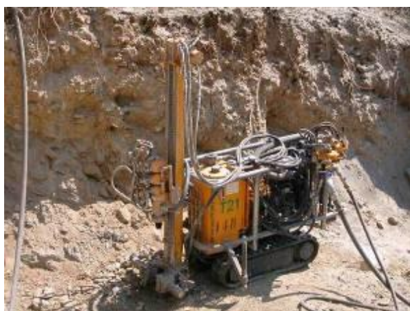
Figura 3-18: Esempio di fondazione con tiranti in roccia
