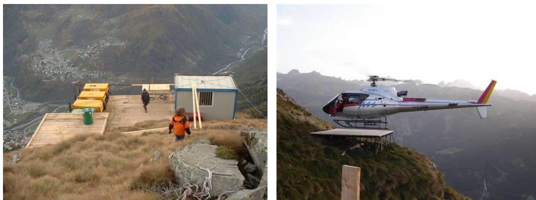
Figura 3-20: Esempi micro - cantieri in quota
