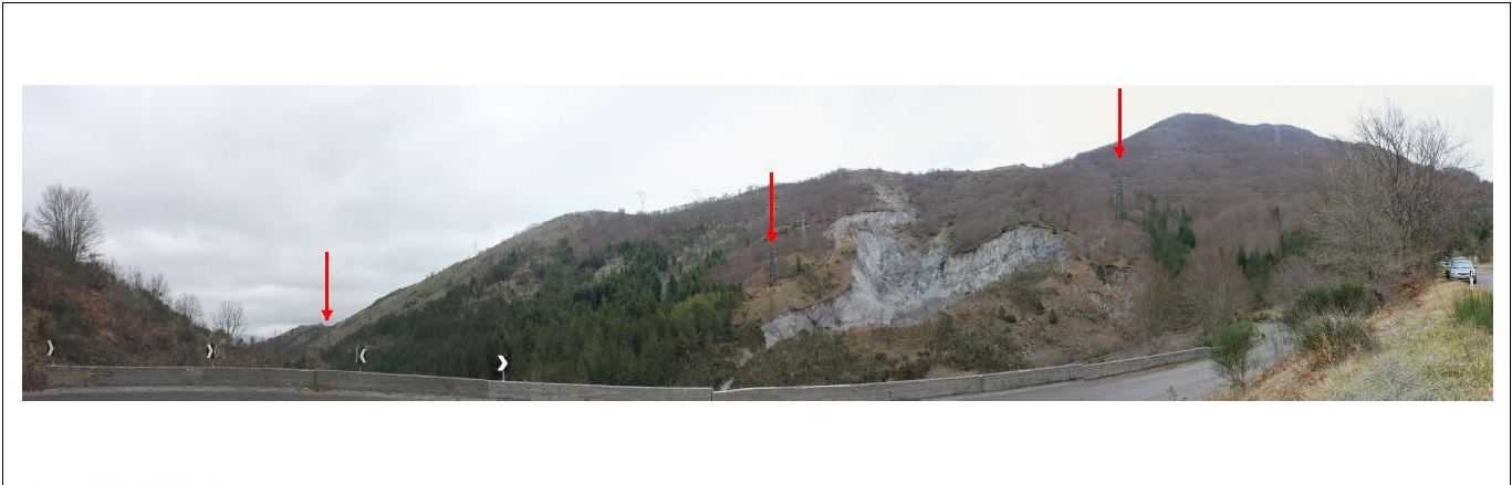
Stato di fatto (→ Demolizioni)
