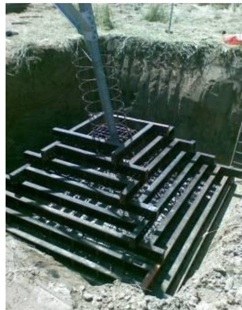
Figura 3-14: Esempio di realizzazione di una fondazione a plinto con riseghe. Nell'immagine di sinistra di può osservare un disegno di progetto mentre nell'immagine di destra la fase di casseratura della fondazione
