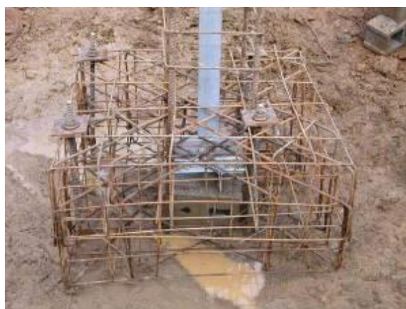
Figura 3-18: Esempio di fondazione con tiranti in roccia
