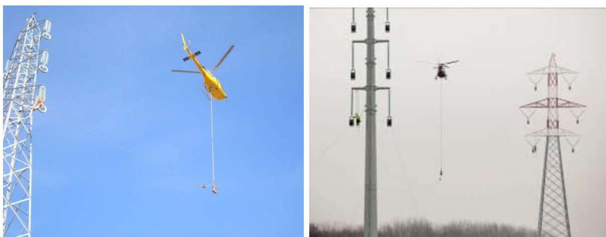
Figura 3-22: Utilizzo dell'elicottero per la stesura della fune pilota
