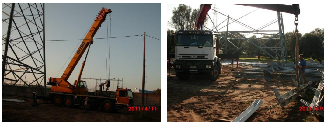
Figura 3-19: Fasi di montaggio sostegno a traliccio
