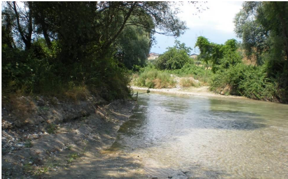
Figura 6-9 – Particolare ambito F. Coscile in prossimità del sostegno 6 - Intervento 4
