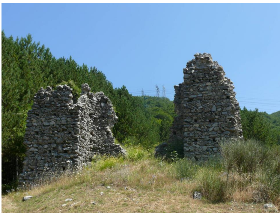
Figura 4-1: Resti del Fortino Borbonico in loc. Colle San Martino
