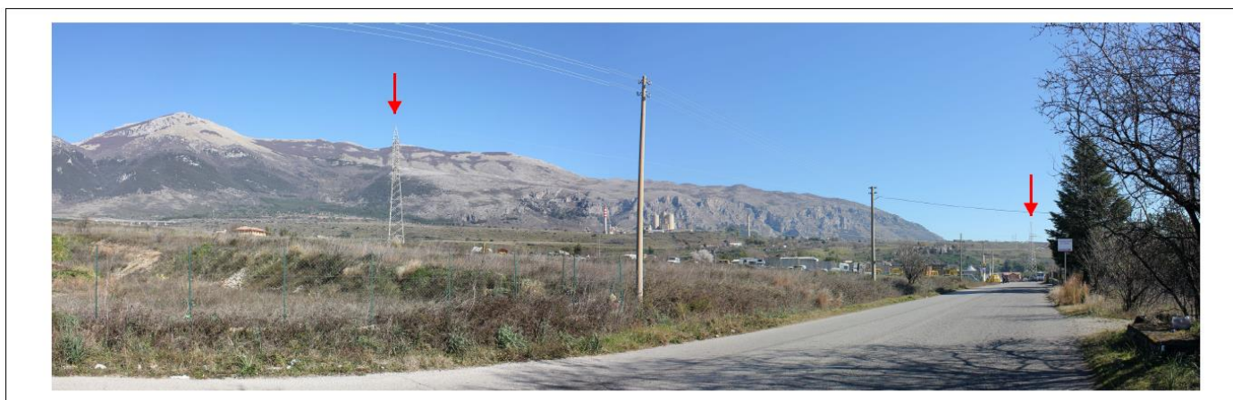
Stato di fatto (→ Demolizioni)
