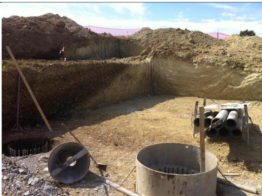
Realizzazione di una fondazione su pali trivellati per un sostegno monostelo. Nell'immagine si può osservare una fondazione in fase di realizzazione. Si possono distinguere facilmente due pali trivellati in realizzazione (si osservano le "riprese" delle gabbie metalliche)
