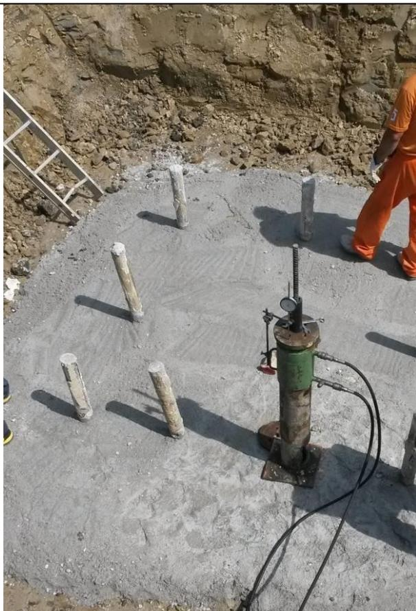
Realizzazione di micropali tipo tubfix per un sostegno a traliccio; si possono osservare i 9 micropali già realizzati ed iniettati; in questa fase, prima dell'armatura e cassetatura del plinto di fondazione, si sta eseguendo una prova di tenuta del micropalo allo strappamento, al fine di verificare la corretta progettazione e realizzazione dello stesso
