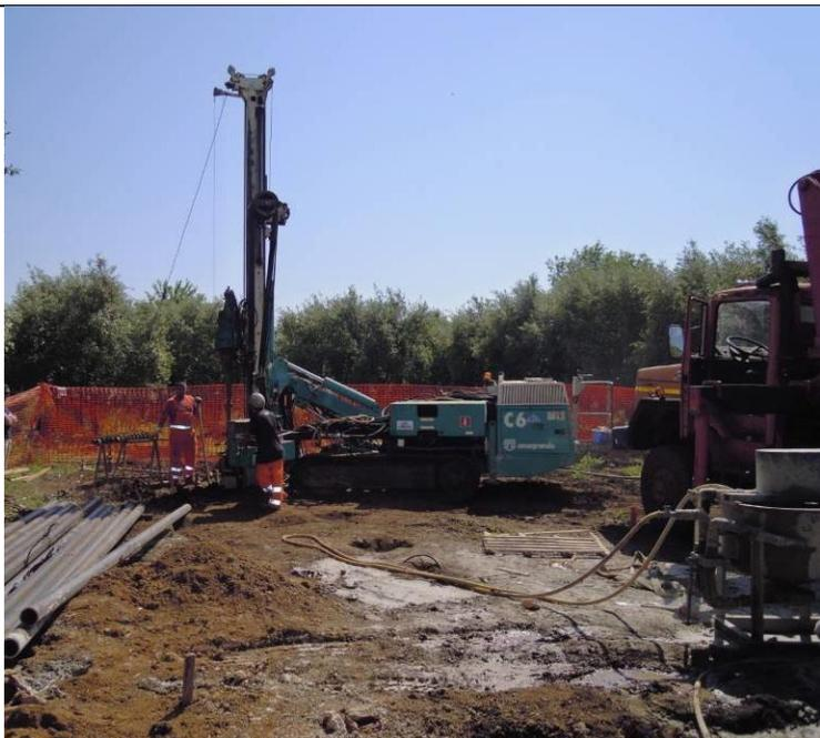
Cantiere per la realizzazione di micropali tipo tubfix; si può osservare sulla sinistra la zona di deposito dei tubolari metallici i quali costituiranno l'armatura dei micropali e sulla destra il miscelatore per la preparazione della boiaccia di cemento per l'iniezione a gravità dei micropali
