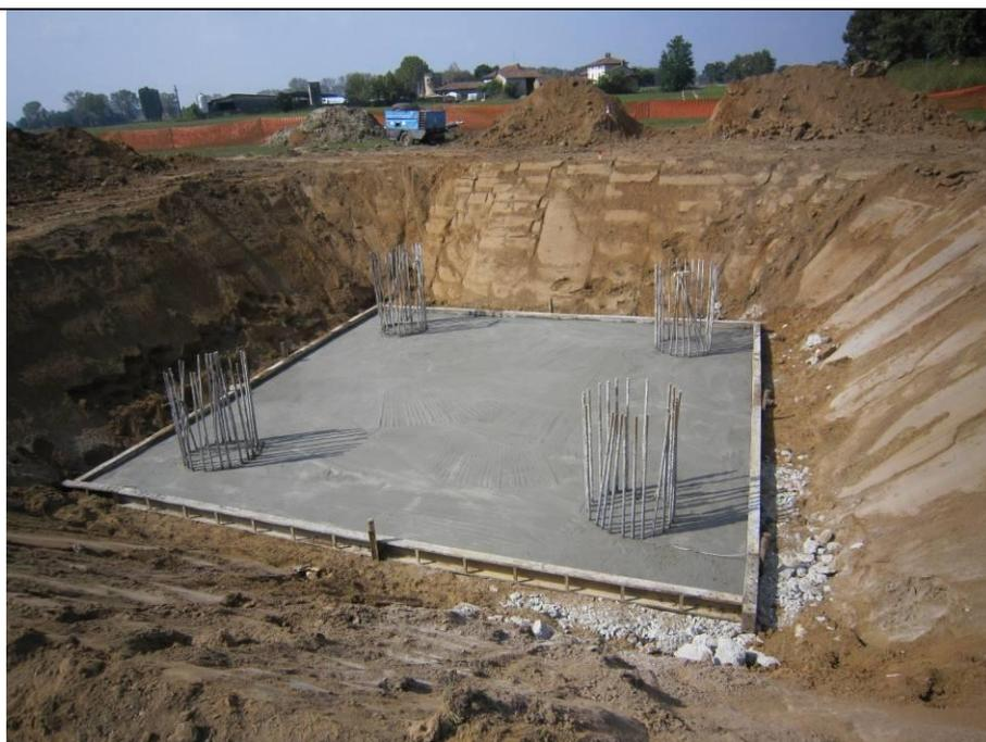
Realizzazione di una fondazione su pali trivellati (nell'esempio quella per un sostegno monostelo). Nell'immagine si può osservare una fondazione in fase di realizzazione. Si possono distinguere facilmente i quattro pali trivellati già realizzati e gettati (si osservano le "riprese" delle quattro gabbie metalliche) ed il piano di "magrone" sul quale impostare il monoblocco in cls
