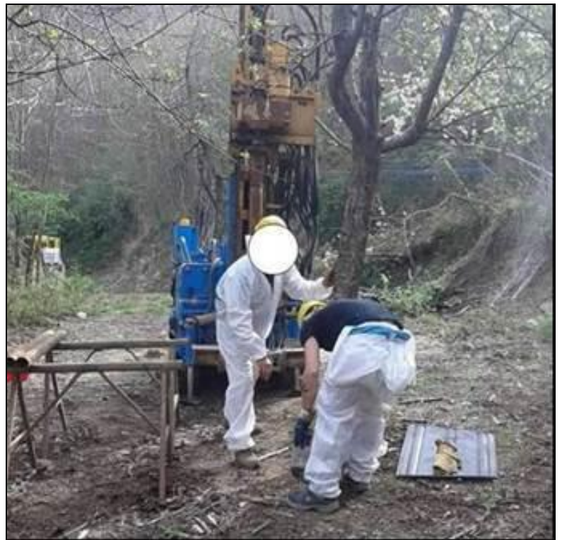
Figura 6-2: Sondaggio effettuato mediante perforazione a carotaggio.
