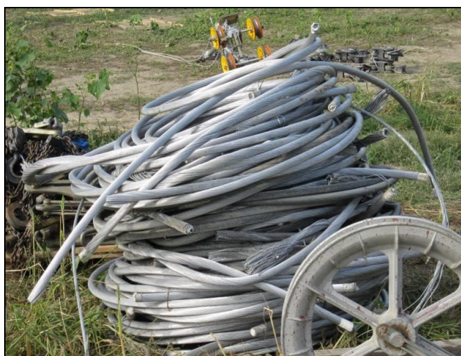
Figura 4-7: Fasi demolizione di un sostegno a traliccio
