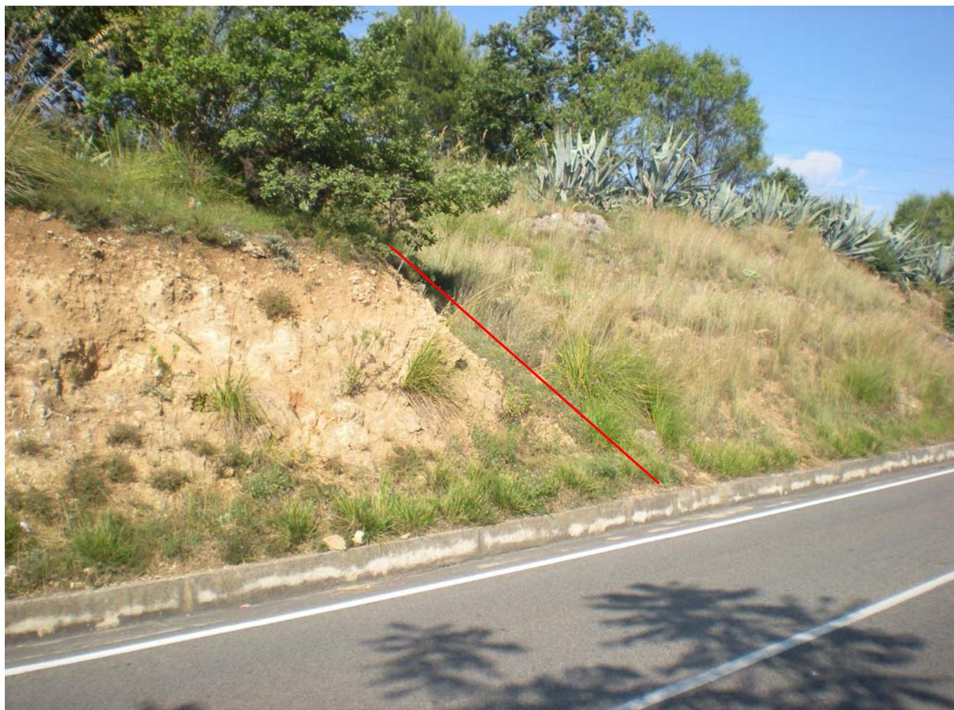
Foto 5: Contatto stratigrafico tra la formazione Sc (a sx) e la formazione SaC (a dx) in corrispondenza del settore compreso tra il sostegno n. 8 e il sostegno n. 9. Il passaggio è evidenziato dalla linea rossa.
