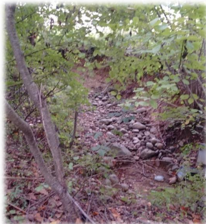
Figura 17 - Alveo del Rio Fossano nei pressi del sostegno 13
