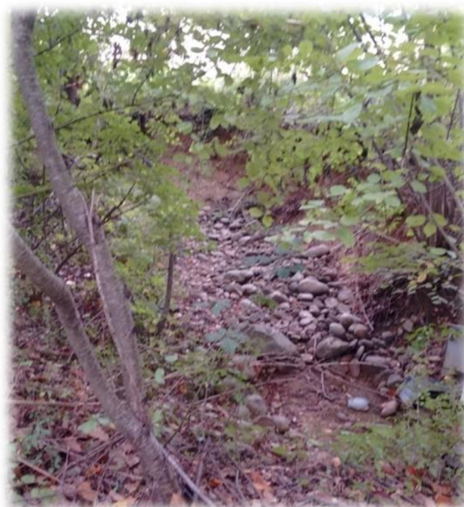
Figura 9 - Alveo del Rio Fossano nei pressi del sostegno p.013N
