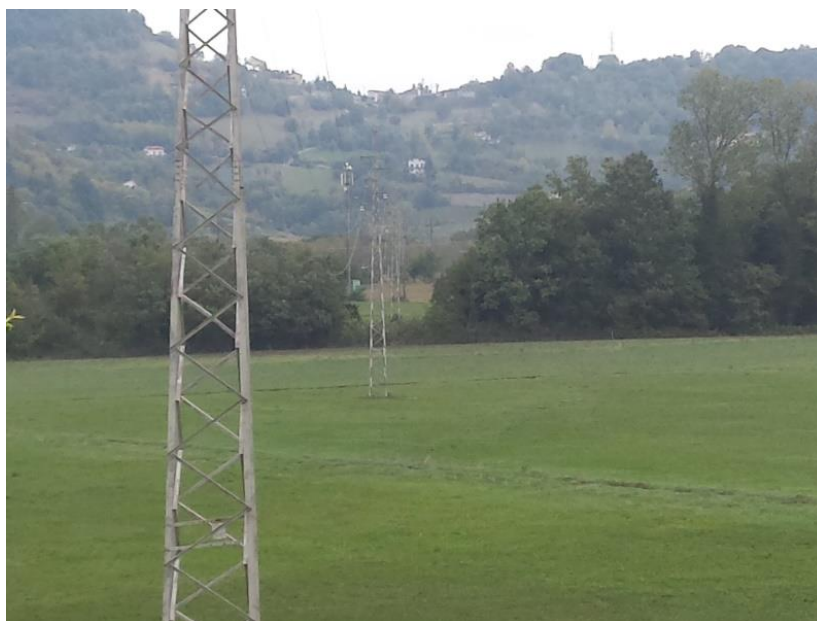
Figura 5 - rea del sostegno 3, coperta dal manto erboso
