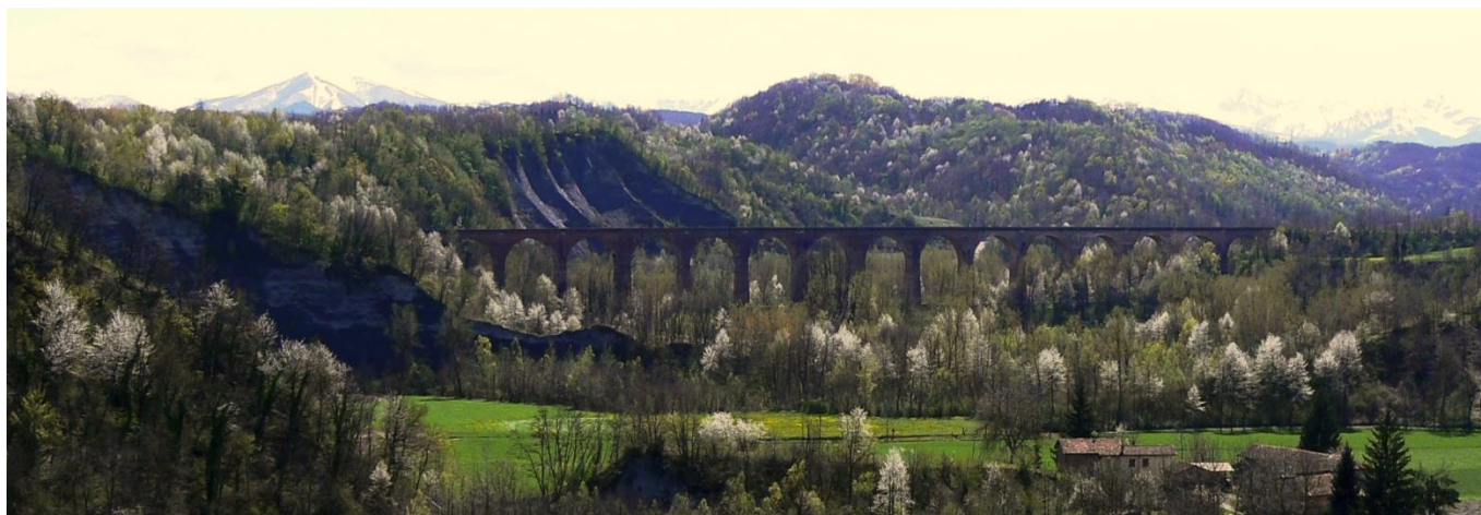
Figura 91: Attraversamento del torrente Mongia con presenza del viadotto ferroviario ante operatem
