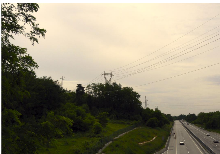
Figura 90: Attraversamento autostrada A6 post operatem
