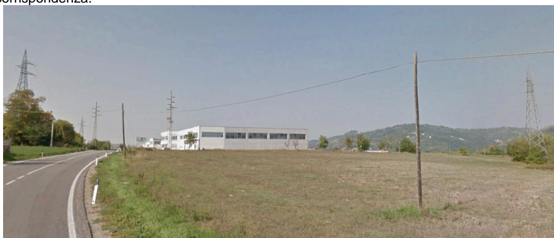
Figura 81: Vista dalla SS 28 dell'attraversamento degli elettrodotti esistenti
