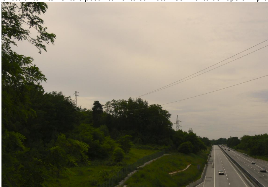
Figura 89: Attraversamento autostrada A6 ante operatem
