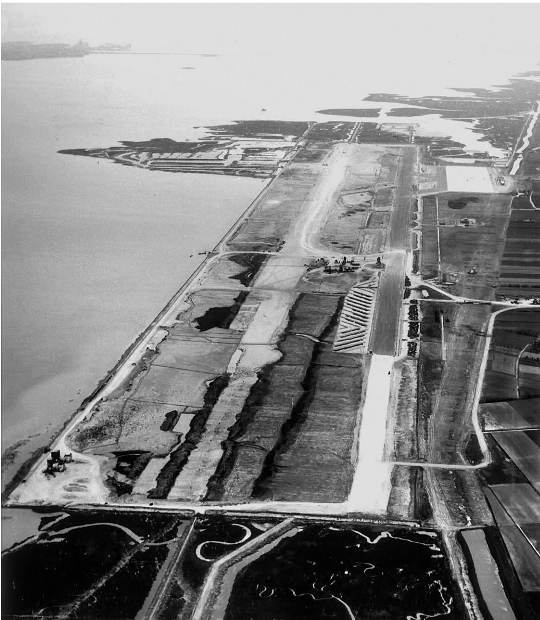
Figura 2-17 L'area dell'aeroporto in realizzazione nel 1960 (Fonte: Resini, 2008).
