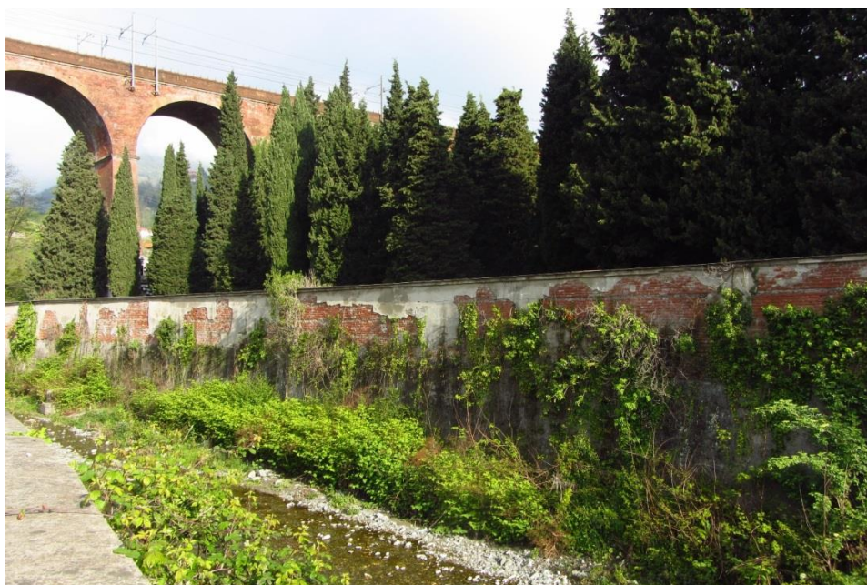
Foto 1. FAU-GE-060. Veduta dell'area di monitoraggio.
