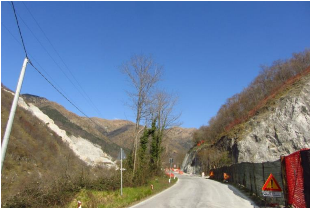
Fig. 1. FAU-CM-040. Panoramica della stazione di monitoraggio.
