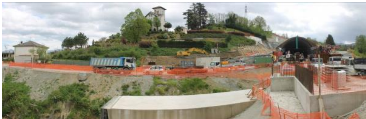
Fig. PAE-AR-030_FT03d – I Corso d'Opera (Punto Foto aggiunto rispetto Ante Operam)
