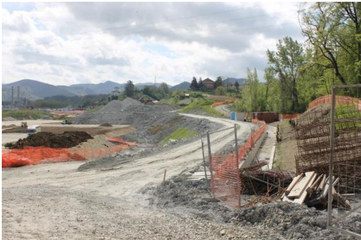
Fig. PAE-AR-030_FT05b – I Corso d'Opera (Punto Foto aggiunto rispetto Ante Operam)
