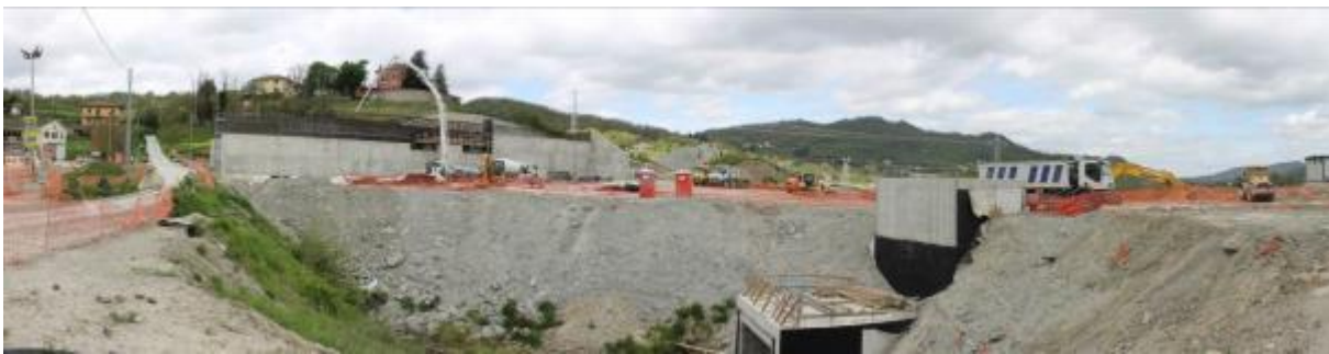
Fig. PAE-AR-030_FT03b – I Corso d'Opera (Punto Foto aggiunto rispetto Ante Operam)
