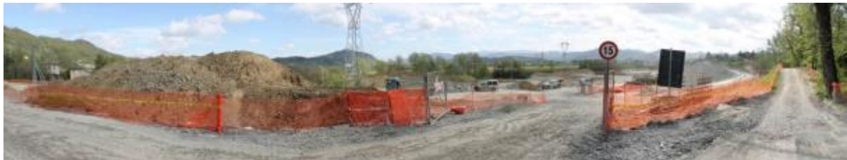
Fig. PAE-AR-030_FT05a – I Corso d'Opera (Punto Foto aggiunto rispetto Ante Operam)
