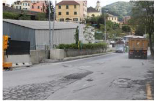
Vista generale 'Via Castel Morrone' Stato di manutenzione: nr Localizzazione di massima: Y: 4921988.25 m N
