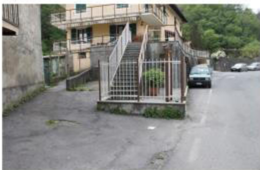
Margine stradale e recinzione in ferro Stato di manutenzione: D Localizzazione di massima: Y: 4930354.07 m N X: 489540.60 m E
