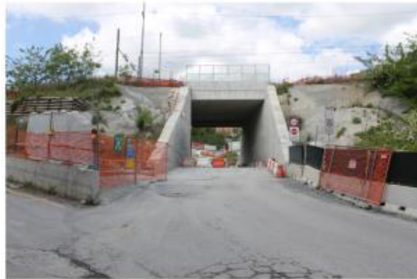
Nuovo ingresso area di cantiere
