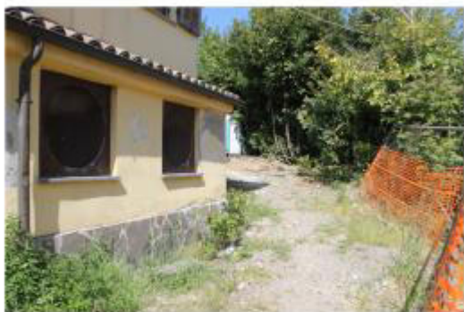
Edificio residenziale Stato di manutenzione: B Localizzazione di massima: Y: 4956191.53 m N
