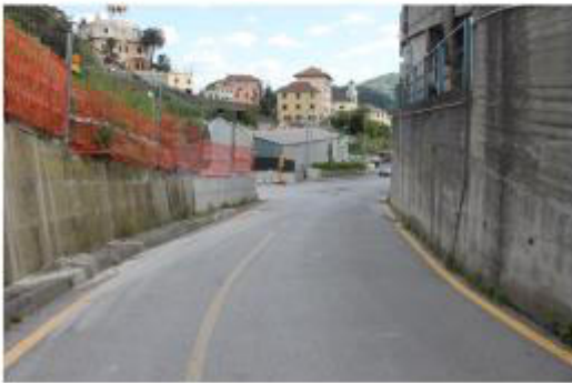
Vista generale 'Via Castel Morrone' Stato di manutenzione: nr Localizzazione di massima: Y: 4921977.12 m N
