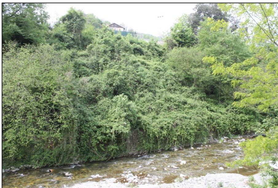
Figura 52 – Vista del CBL5 dalla SP6
