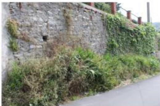
Scarpata Stato di manutenzione: P Localizzazione di massima: Y: 4922052.62 m N X: 491031.21 m E
