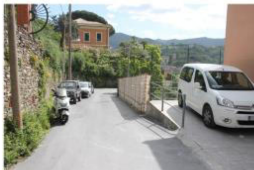
Margine stradale Stato di manutenzione: D Localizzazione di massima: Y: 4922048.90 m N X: 491048.68 m E
