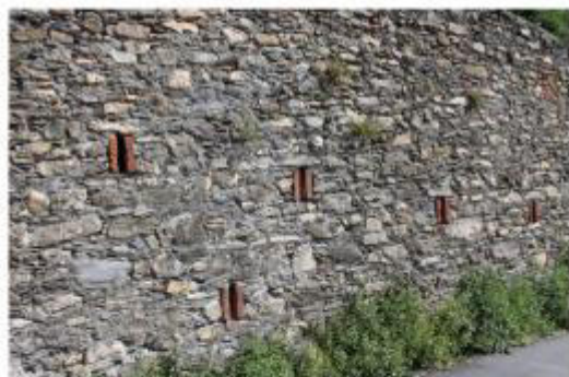
Muro Stato di manutenzione: D Localizzazione di massima: Y: 4922048.90 m N X: 491048.68 m E
