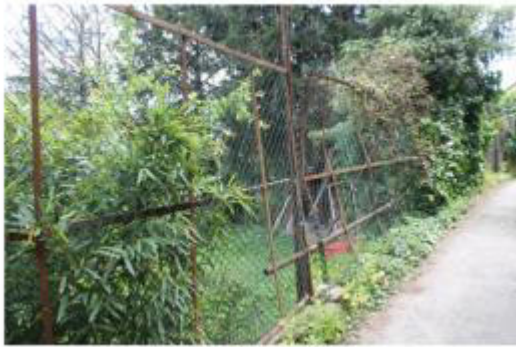
Recinzione metallica Stato di manutenzione: C Localizzazione di massima: Y: 4926335.76 m N X: 491921.17 m E
