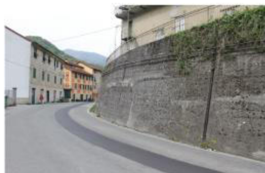
Muro di contenimento Stato di manutenzione: D Localizzazione di massima: Y: 4930365.34 m N X: 489518.10 m E
