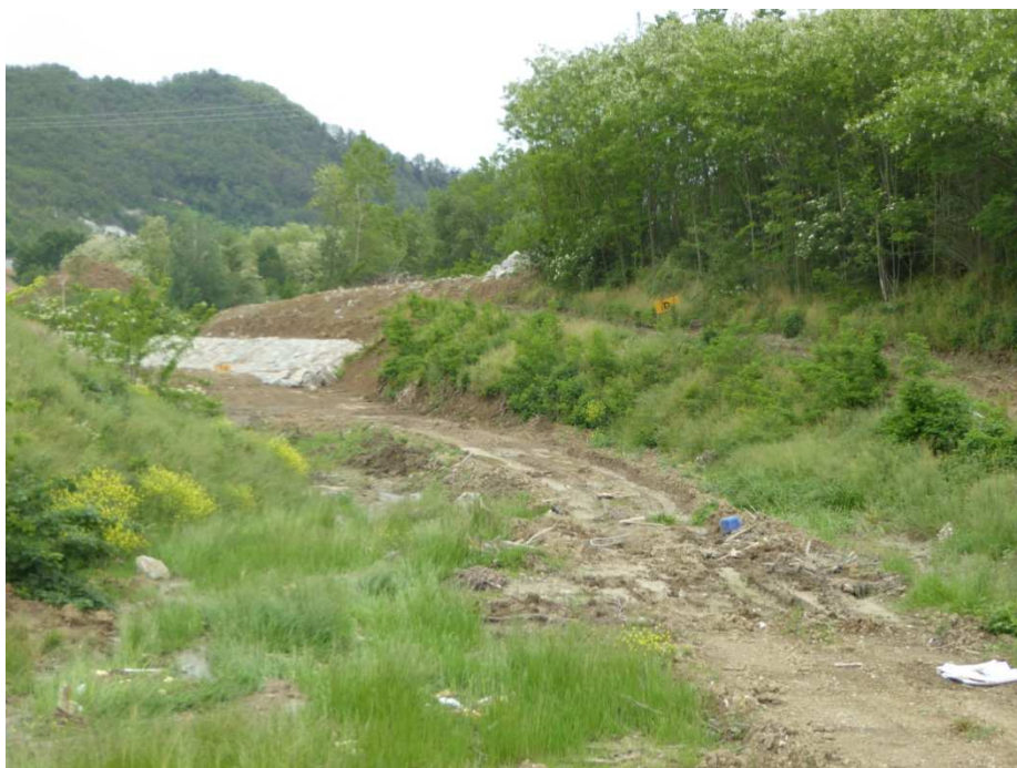
Figura 13.12.3: panoramica stazione di rilievo VEG-AR-500B
