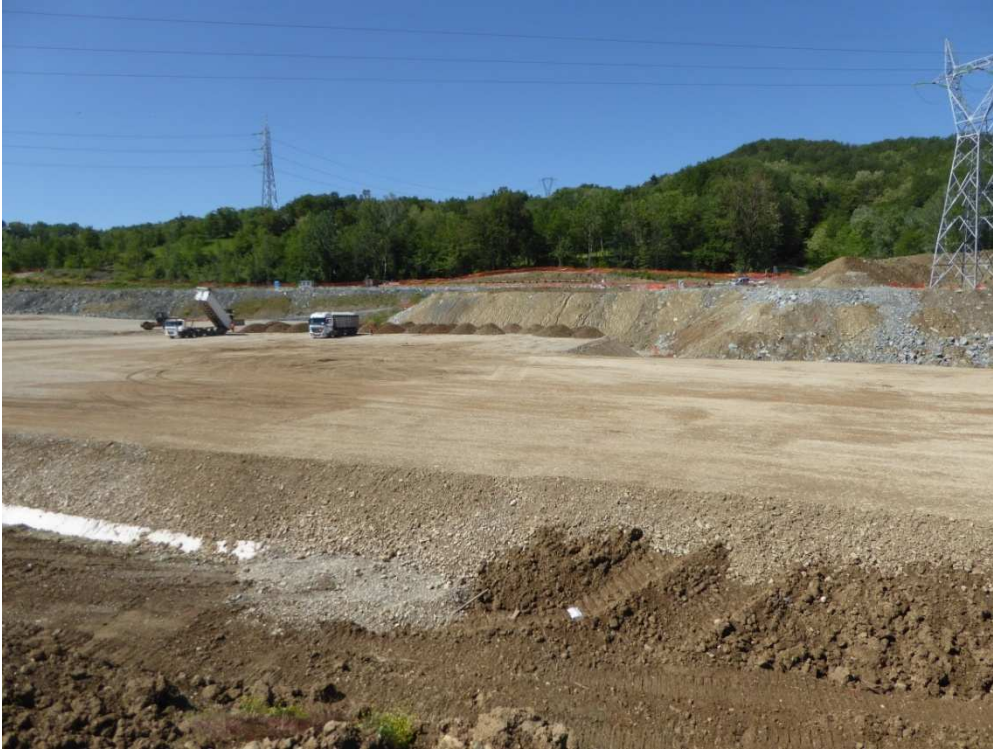
Figura 13.17.3: panoramica stazione di rilievo VEG-SS-500D
