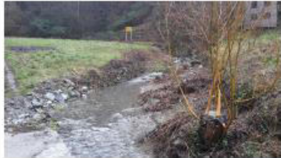
Foto della stazione verso monte
