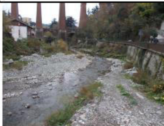
Foto della stazione verso monte
