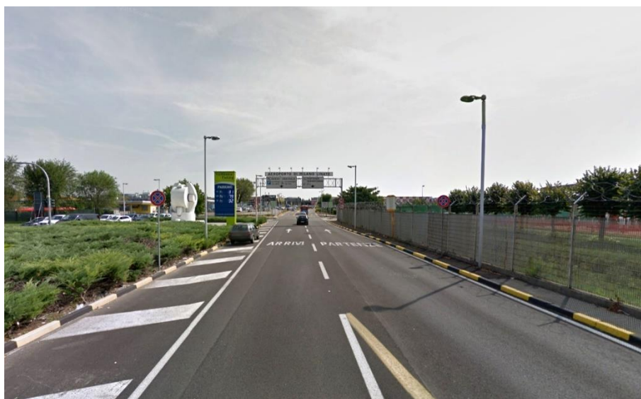
Figura 10-18 Punto di vista di Viale Enrico Forlanini (Milano)
