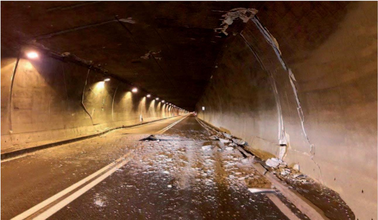
Figura 7: frattura nel rivestimento di una galleria nei pressi di Norcia in seguito ai terremoti succedutisi dal 24 agosto 2016 nell'Italia Centrale. E' intuibile l'entità dei danni che fenomeni simili possono causare su tubazioni verticali ed orizzontali e sugli impianti anche se realizzati nel rispetto della legge antisismica vigente.
