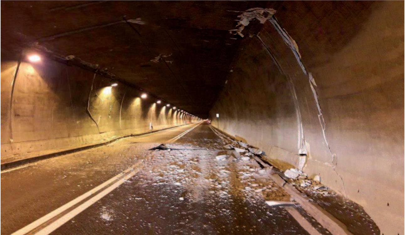
Figura 9: frattura nel rivestimento di una galleria nei pressi di Norcia in seguito ai terremoti succedutisi dal 24 agosto 2016 nell'Italia Centrale. E' intuibile l'entità dei danni che fenomeni simili possono causare su tubazioni verticali ed orizzontali e sugli impianti anche se realizzati nel rispetto della legge antisismica vigente.
