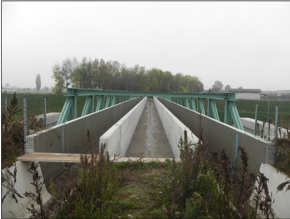
Attraversamento di due canalette irrigue e per pedoni
