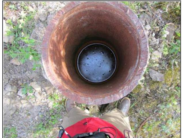
Fig. 23 A,B. A. sinistra: rottura del tappo di cemento di un pozzo abbandonato; a destra: un pozzo abbandonato aperto.
