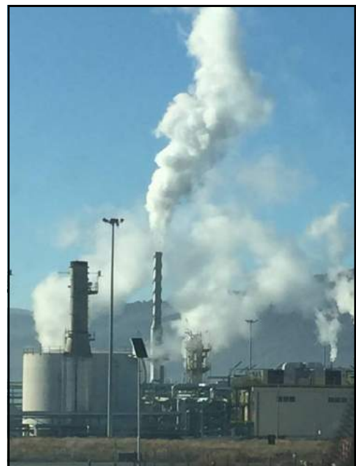
Fig. 6 - Violenti episodi di emissioni di fumi e sostanze inquinanti dal Centro Olio Val d'Agri.
