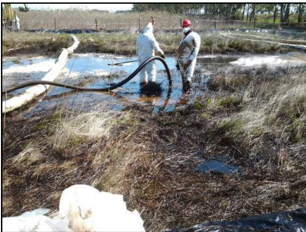
Fig. 10 A,B - Sversamento di petrolio sul suolo per rottura dell'oleodotto che trasporta il petrolio della Val d'Agri alla raffineria di Taranto (Foto di P. Acito).
