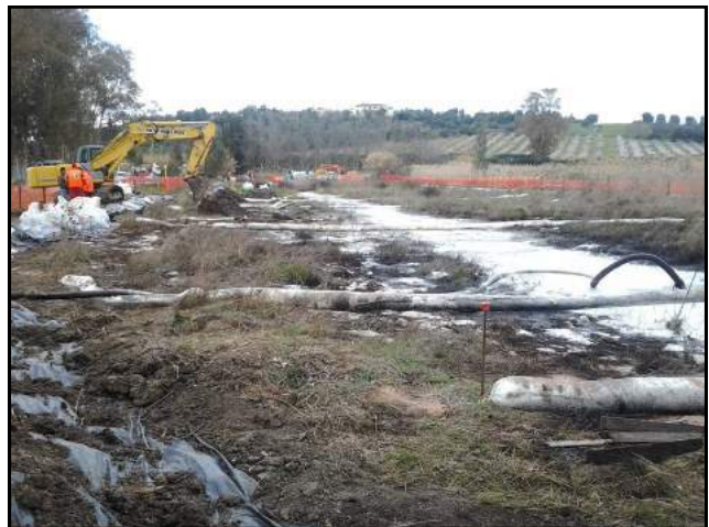
Fig. 10 A,B - Sversamento di petrolio sul suolo per rottura dell'oleodotto che trasporta il petrolio della Val d'Agri alla raffineria di Taranto (Foto di P. Acito).
