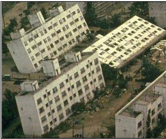
Fig. 36 - A sinistra: effetti della liquefazione del terreno a seguito del terremoto di Niigata (Giappone) nel 1964. A destra: raffinerie di petrolio distrutte in Giappone dal violento terremoto del 2011 e dall'associato maremoto-
