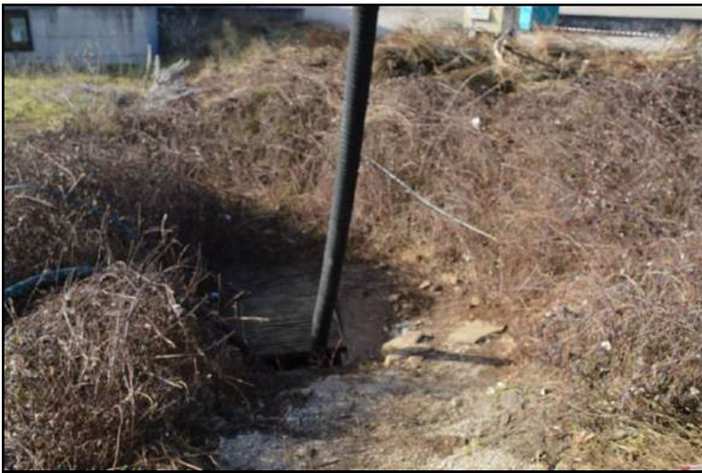
Fig. 9 A,B - Fuoriuscita di liquami con idrocarburi da tubazioni nel sottosuolo del COVA, e interventi di bonifica con aspirazione dei fluidi (Foto A. Alberti).
