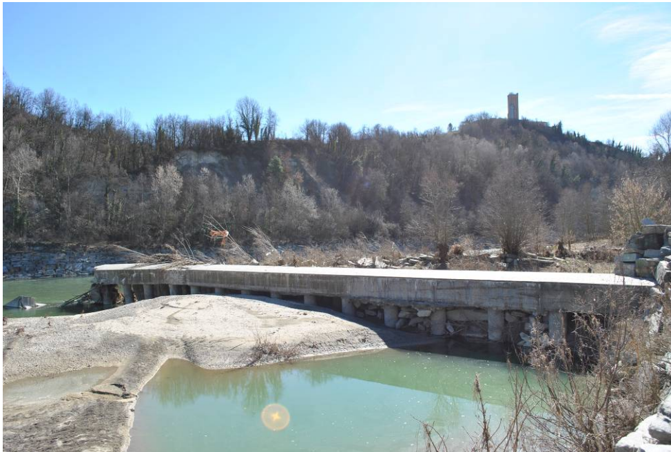
Traversa esistente, parzialmente crollata e insabbiata, da nord ( punto di scatto 9 )
