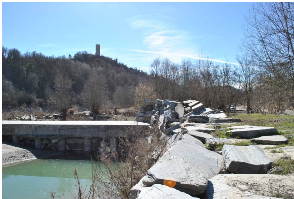
Massicciata a lato (a ovest/nord-ovest) della traversa esistente ( punto di scatto 9 )
