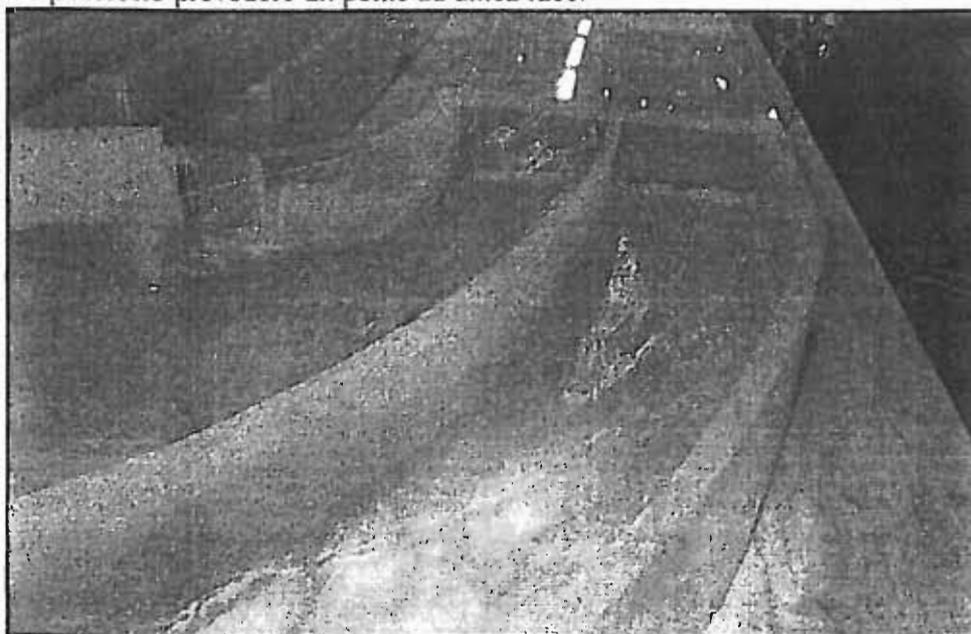
*Foto10 - Setto posto allo sbocco del bypass per favorire il deflusso delle portate.*
