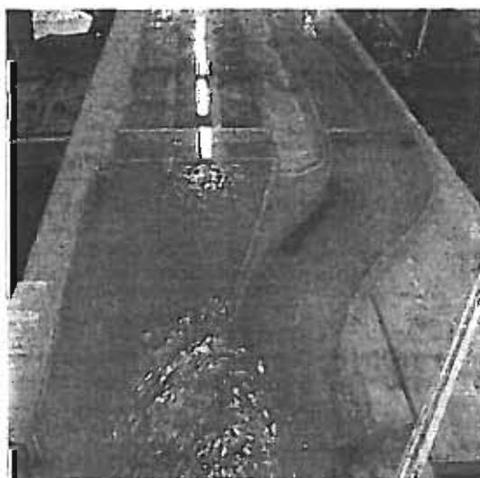
*Foto10 – Setto posto allo sbocco del bypass e del Mugnone per favorire il deflusso delle portate*
