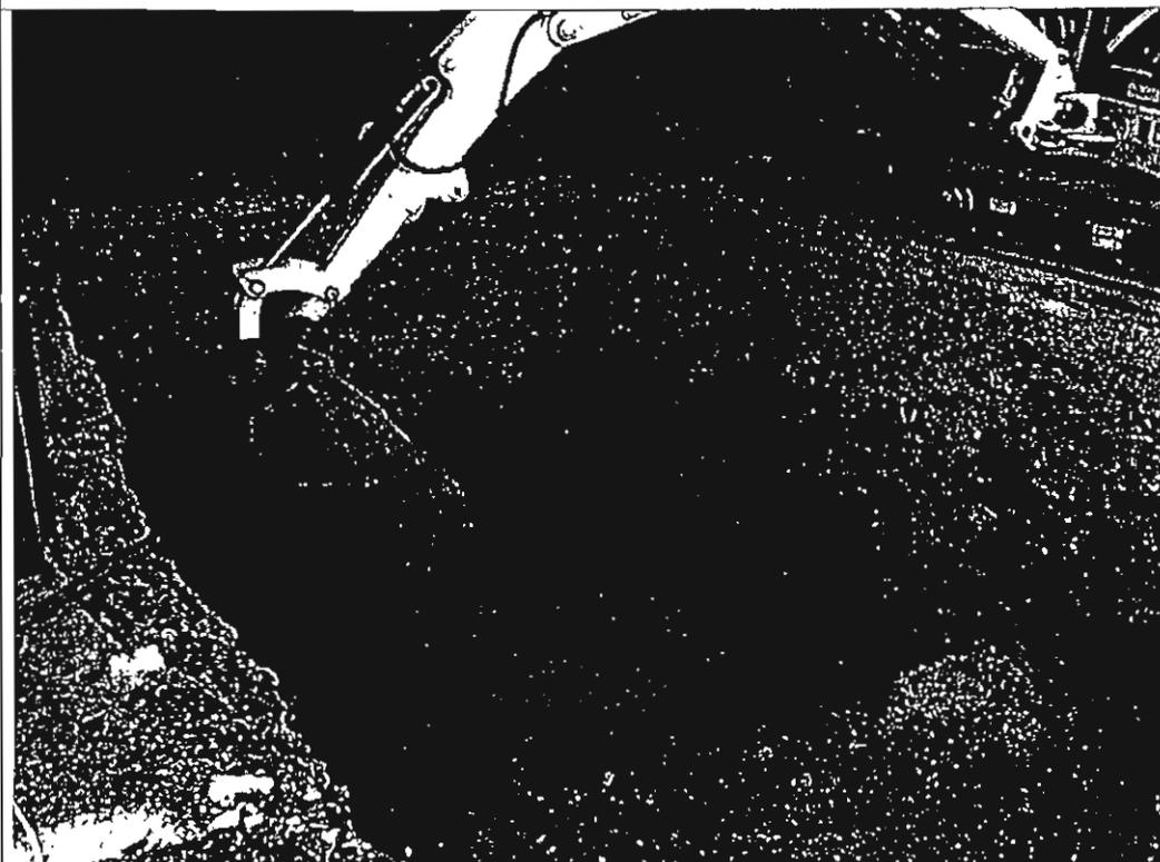
Foto 2 : preparazione del piano di posa vasca interrata.
