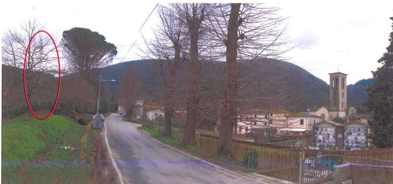
Figura 6.4-2: Vista lungo via di Cerasomma in direzione sud-est. In primo piano è visibile l'attraversamento della viabilità storica locale in prossimità del cimitero. È evidenziato in rosso il sostegno n. 59 esistente.
