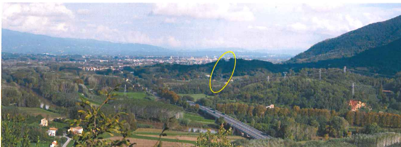
Figura 1.3-1: Vista dall'area del Castello di Cotone in direzione ovest. In primo piano è visibile il tratto autostradale della Firenze-Mare in prossimità dell'attraversamento del fiume Serchio. In secondo piano è visibile il tracciato esistente oggetto del presente studio (evidenziato in giallo).
