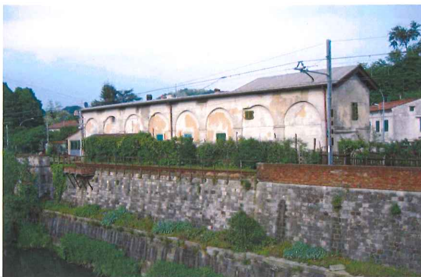
Figura 3.1-1: ex stazione di Ripafratta, lungo la ferrovia storica Lucca-Pisa
