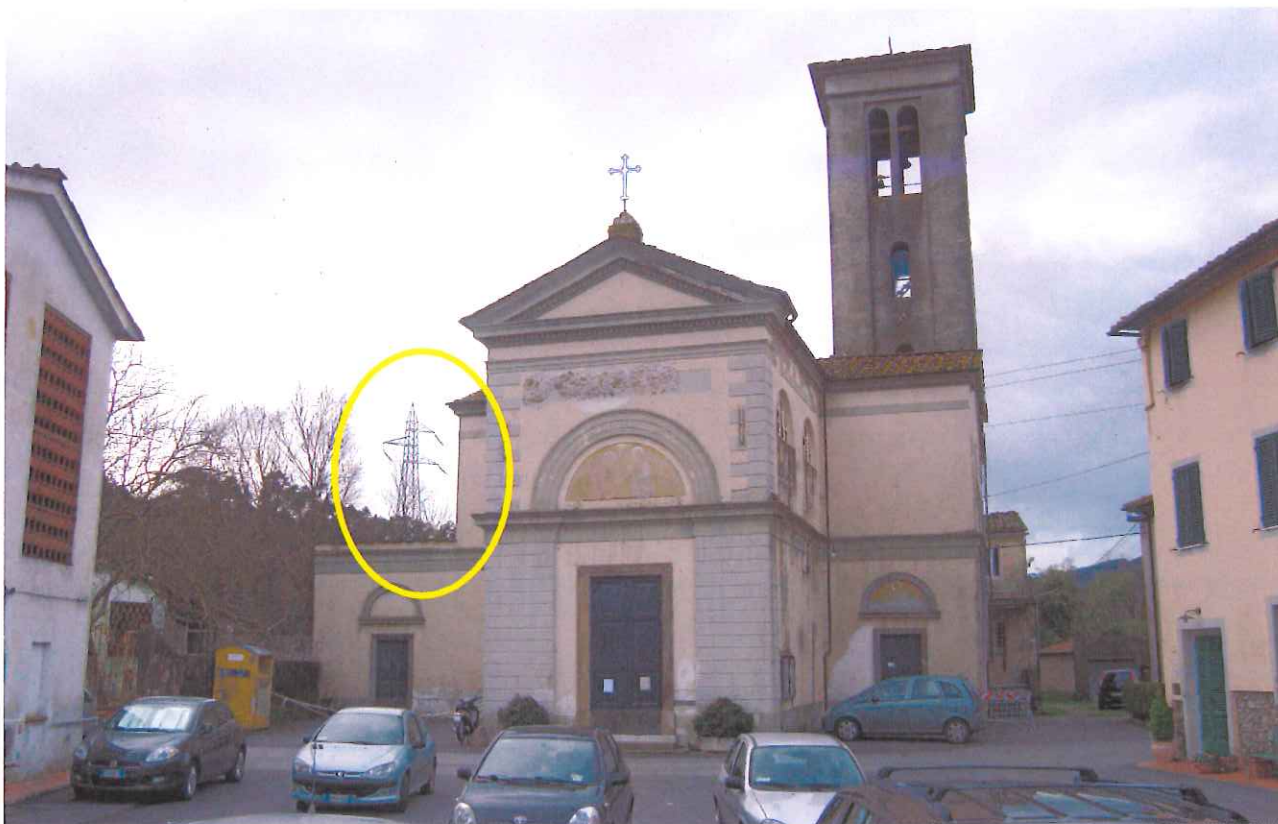
Figura 6.4-12: Chiesa di San Pietro Apostolo a Cerasomma. In giallo è evidenziato il sostegno n. 60 della linea esistente
