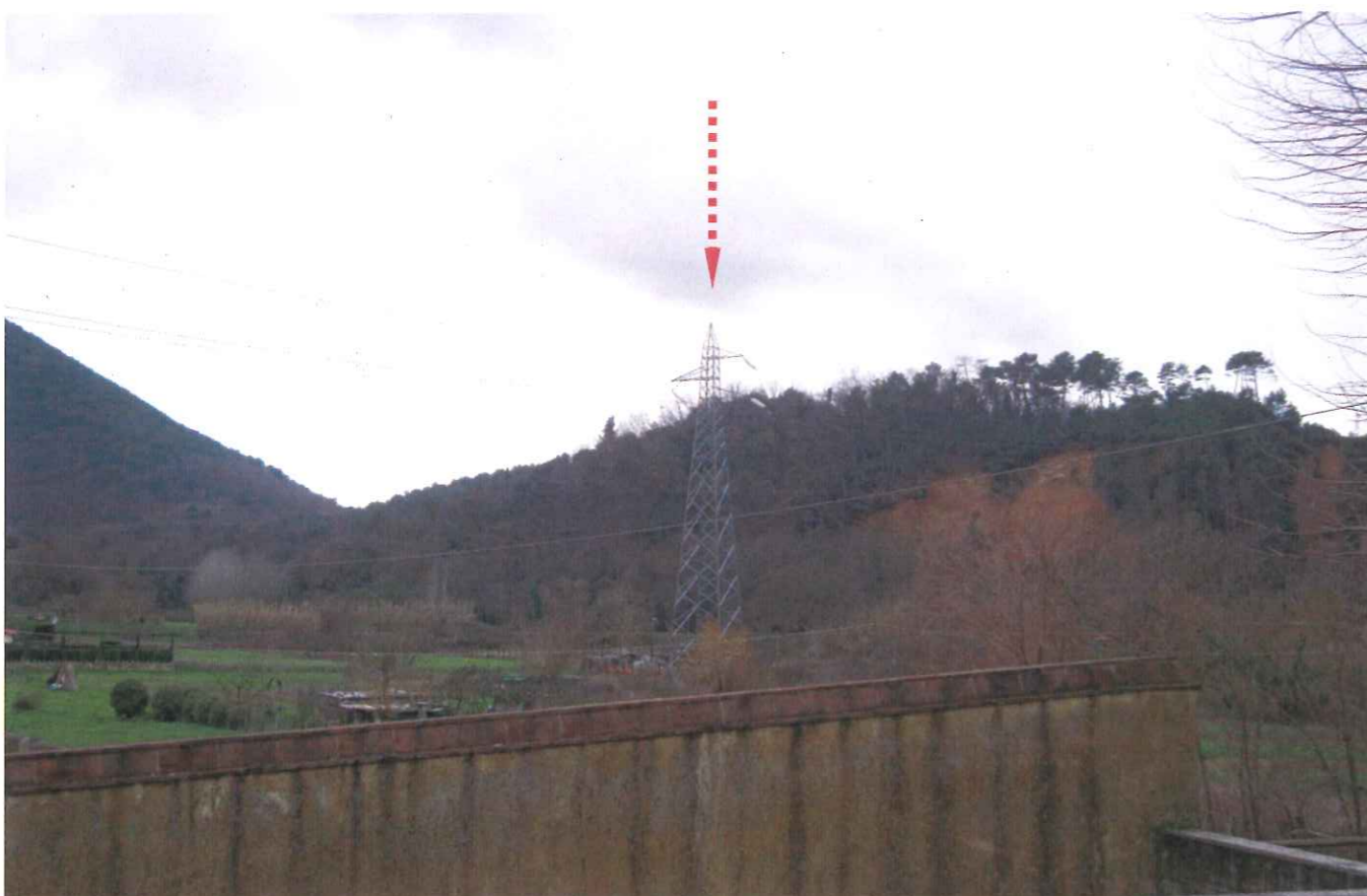
Foto 5b: Vista ravvicinata del sostegno n°60 della linea 132kV esistente posizionato in località Menesini. Nella foto, alle spalle del sostegno, si può notare il colle di Poggio Luce.
