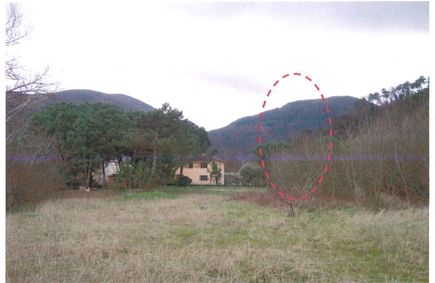
Foto 4b: Vista in direzione sud verso località Vignale. L'area tratteggiata indica la posizione approssimativa del sostegno 60bis della variante autorizzata da non realizzare.
