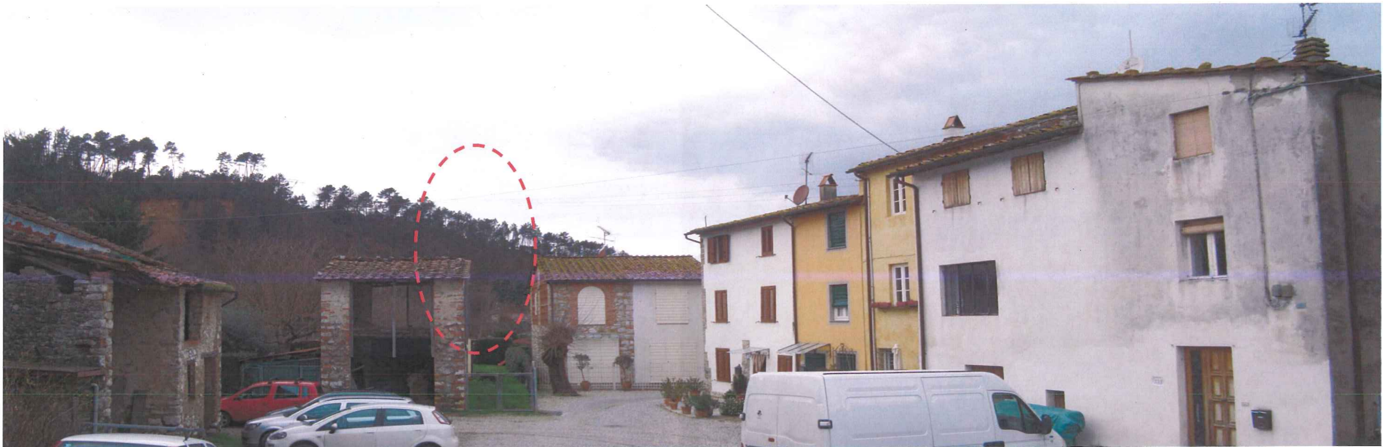
Foto 14: Vista da via della Chiesa Quarta in direzione ovest verso il colle di Poggio Luce appena visibile nella foto. L'area tratteggiata indica la posizione, approssimativa, del sostegno n°60bis della variante autorizzata da non realizzare.
