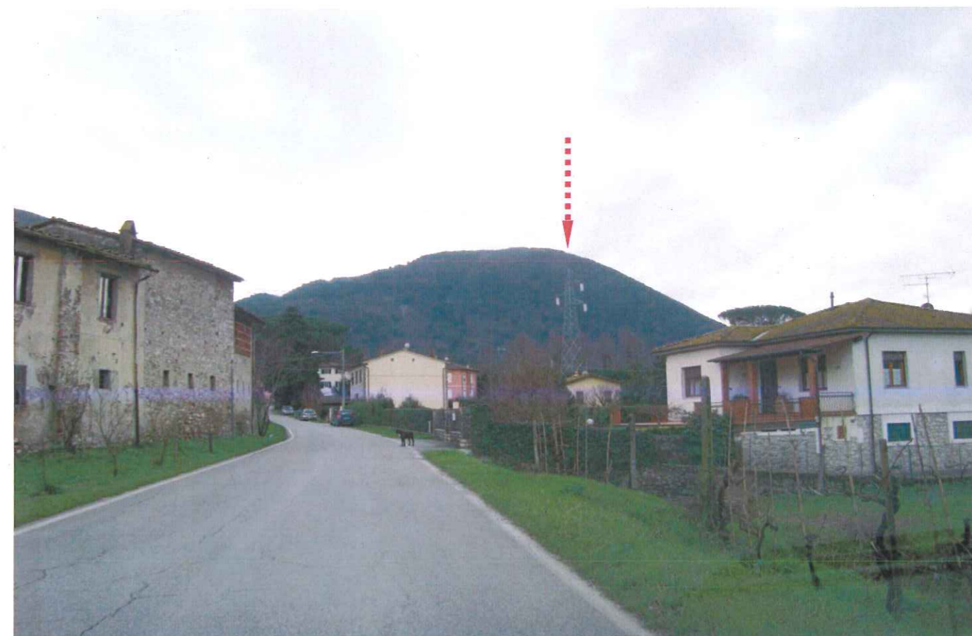
Foto 12: Vista di via di Cerasomma in direzione sud verso la frazione di Cerasomma. La freccia indica il sostegno n°59 della linea 132kV esistente (coincidente con la variante localizzativa in esame).
