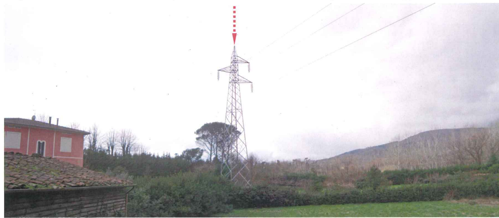
Foto 9a: Vista da via di Cerasomma in direzione sud-ovest. La freccia indica la posizione del sostegno n° 59 della linea 132kV esistente (coincidente con la variante localizzativa in esame).
