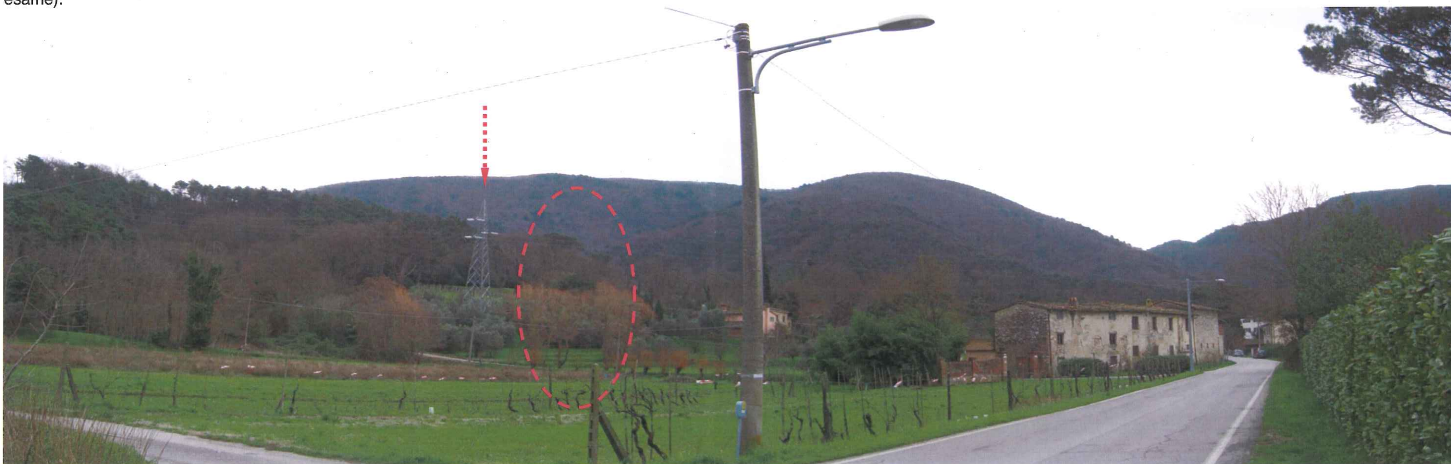
Foto 11a: Vista lungo via di Cerasomma in direzione sud verso frazione Cerasomma. La freccia indica il sostegno n°58 della linea 132kV esistente (coincidente con la variante localizzativa in esame). L'area tratteggiata indica la posizione, approssimativa, del sostegno n°59 della variante autorizzata da non realizzare.
