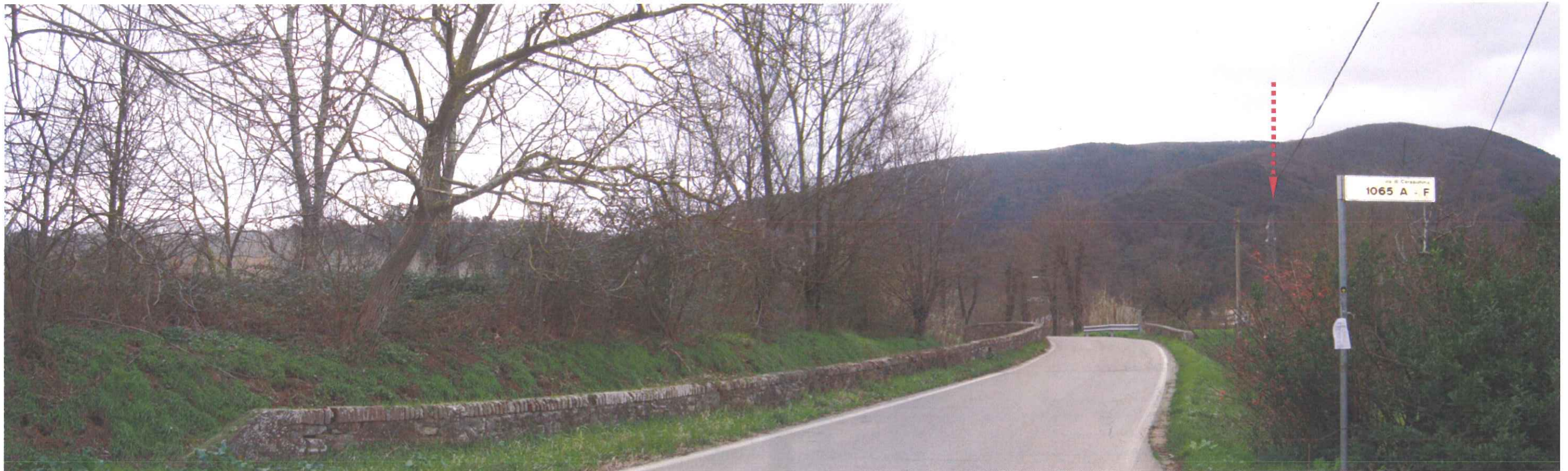
Foto 1: Vista lungo via di Cerasomma in direzione sud-est. Nella foto è visibile il sostegno n°60 della linea 132 kV esistente (coincidente con la variante localizzativa in esame) posizionato in prossimità del cimitero di Cerasomma.
