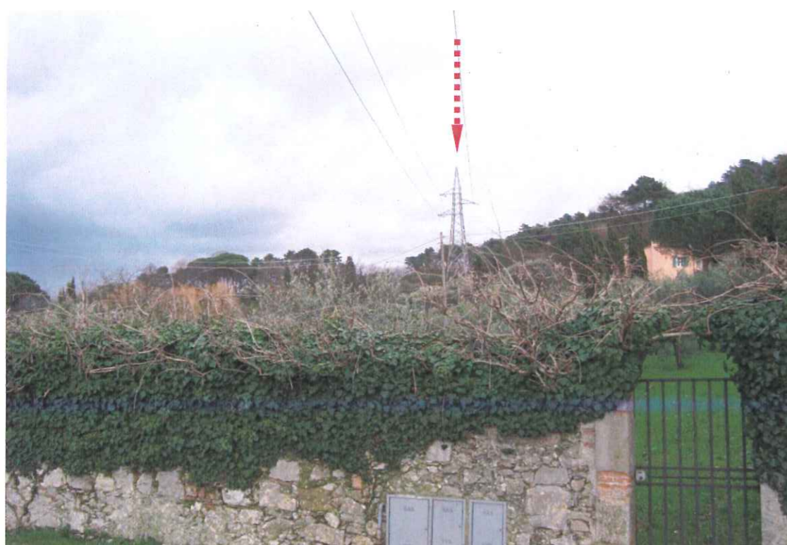
Foto 9b: Vista da via di Cerasomma in direzione sud-ovest, del sostegno n°58 della linea 132 kV esistente (coincidente con la variante localizzativa in esame).
