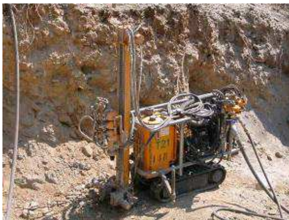
Figura 63: Esempio di fondazione con tiranti in roccia
