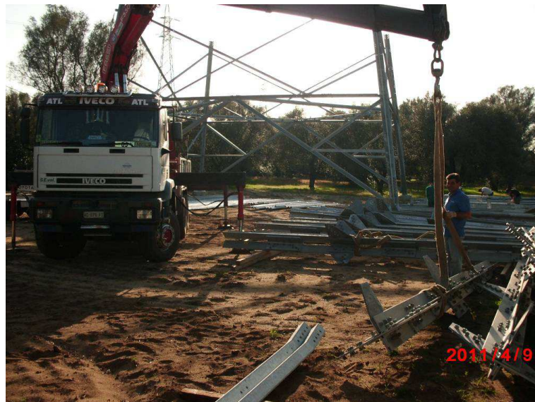
Figura 83: Fasi di montaggio sostegno a traliccio
