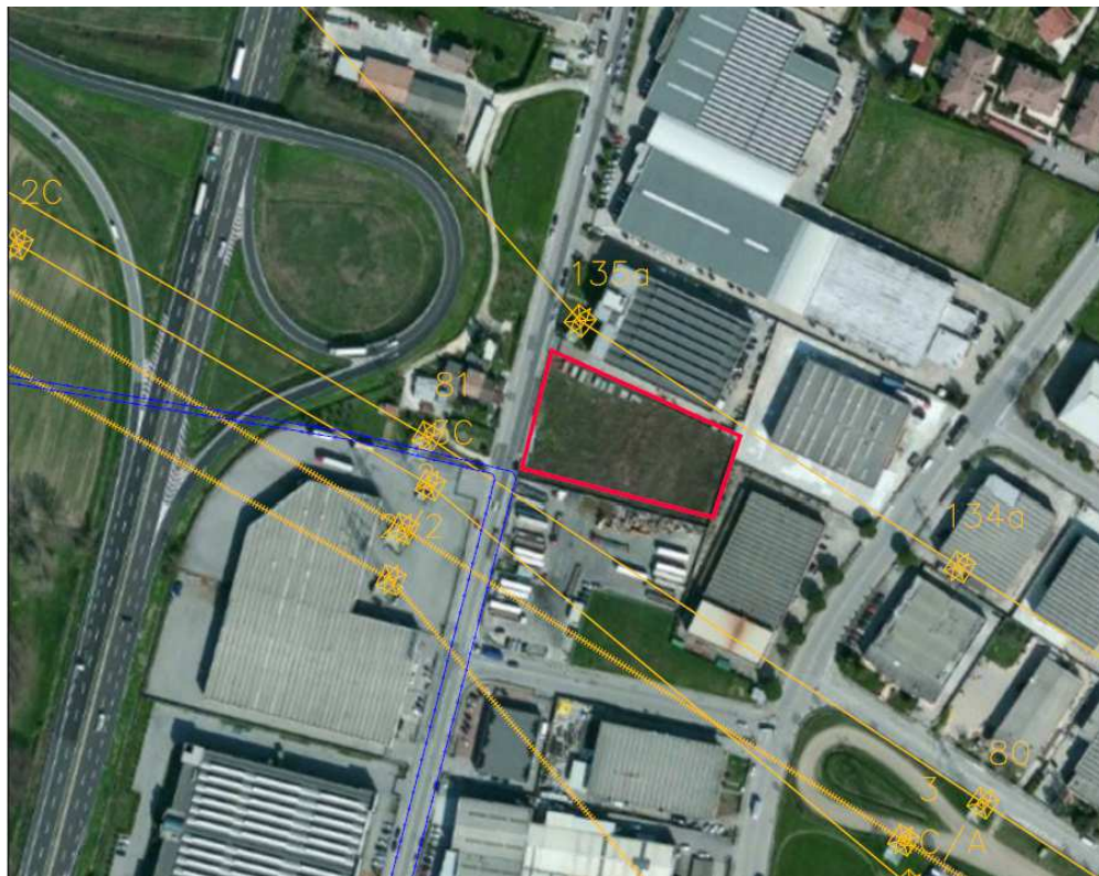
Figura 43: Cantiere base a servizio degli interventi nell'ambito A – Area incolta già utilizzata come deposito, interclusa nell'area industriale di Camin (Comune di Padova)
