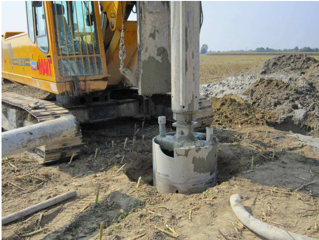
Figura 70: Macchina operatrice per la realizzazione di pali trivellati. Particolare del “carotiere”
