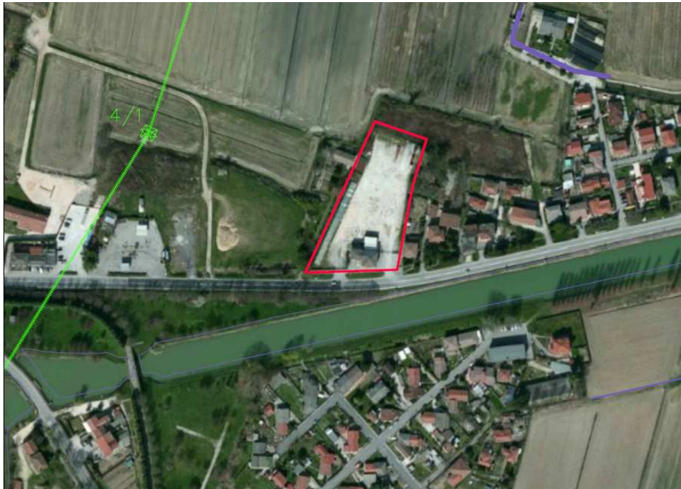
Figura 44: Cantiere base a servizio degli interventi nell'ambito C – Area già utilizzata come deposito di mezzi pesanti in Comune di Venezia
