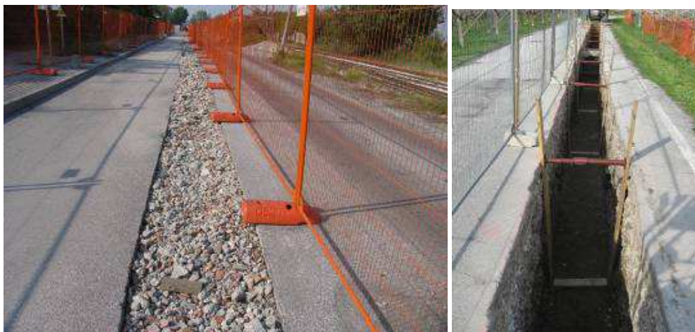
Figura 90: Taglio dell'asfaltatura e scavo aperto
