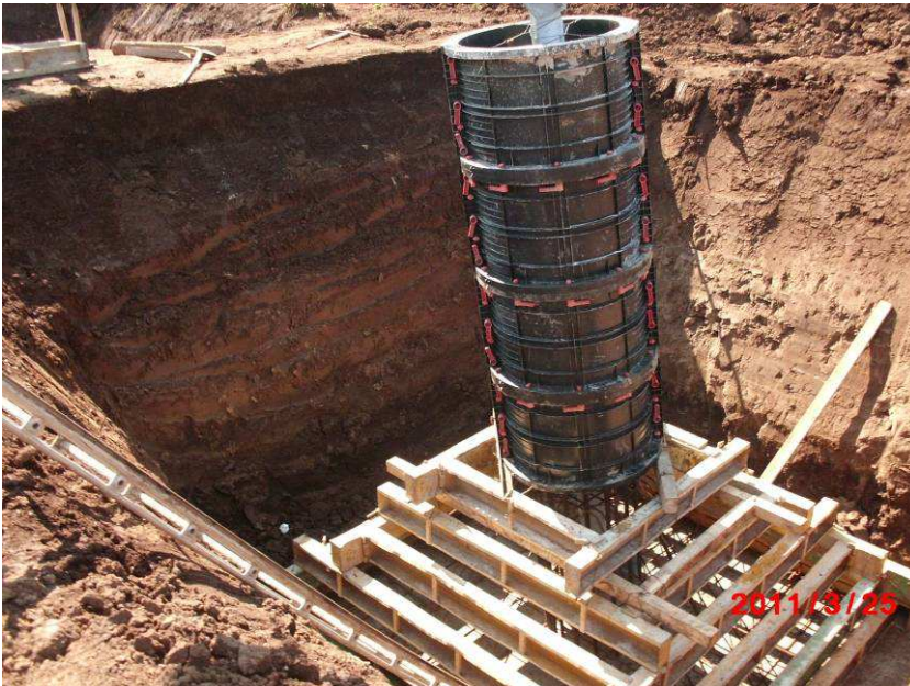
Figura 60: Realizzazione di fondazioni superficiali tipo CR per un sostegno a traliccio. Nell'immagine si può osservare la fase di cassetatura
