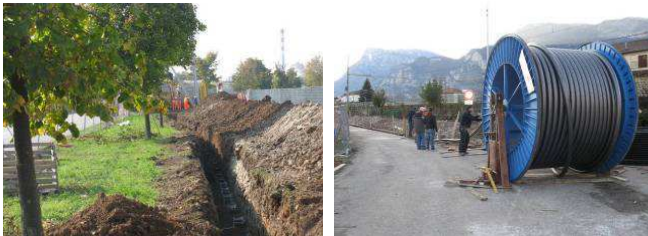
Figura 91: Posa rulli lungo lo scavo e stendimento del cavo
