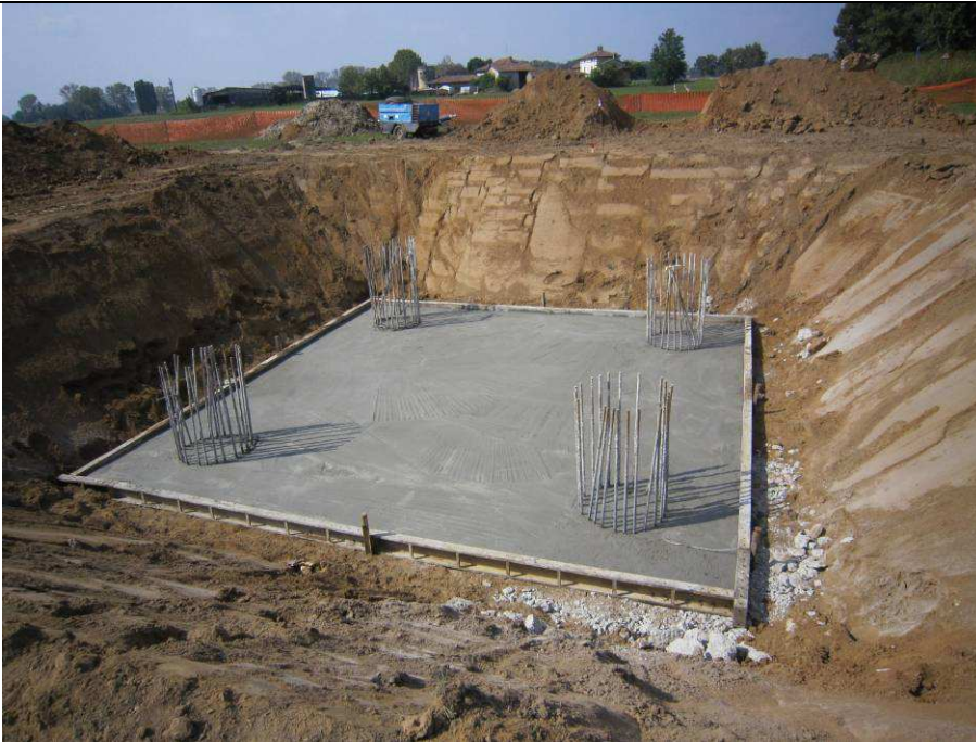
Figura 72: Realizzazione di una fondazione su pali trivellati per un sostegno monostelo. Nell'immagine si può osservare una fondazione in fase di realizzazione. Si possono distinguere facilmente i quattro pali trivellati già realizzati e gettati (si osservano le "ripresе" delle quattro gabbie metalliche) ed il piano di "magrone" sul quale impostare il monoblocco in cls
