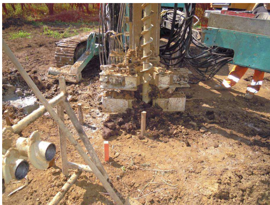
Figura 78: Macchina operatrice per la realizzazione di micropali tubfix; sistema di scavo mediante trivella elicoidale
