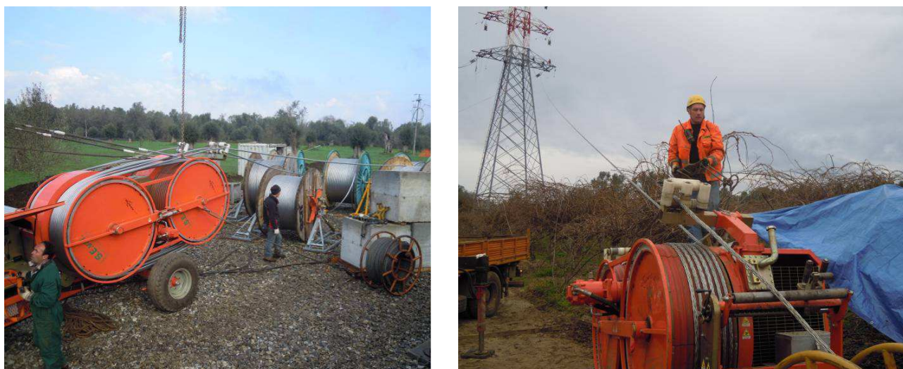
Figura 85: Fasi di tesatura della linea elettrica
