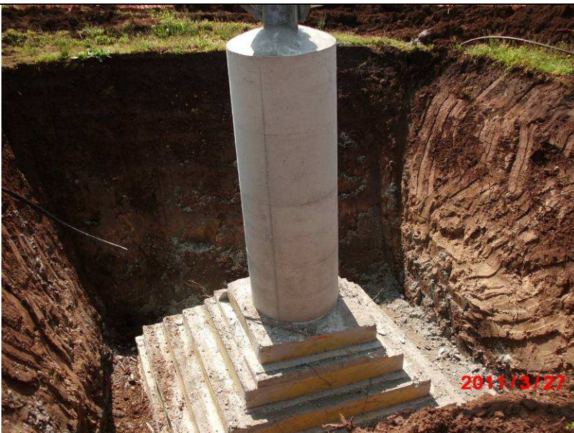
Figura 61: Realizzazione di fondazioni superficiali tipo CR per un sostegno a traliccio. Nell'immagine si può osservare una fondazione CR appena "scasserata". Si possono distinguere facilmente la parte inferiore a parallelepipedi tronco piramidali ed il colonnino di raccordo con la "base" del sostegno
