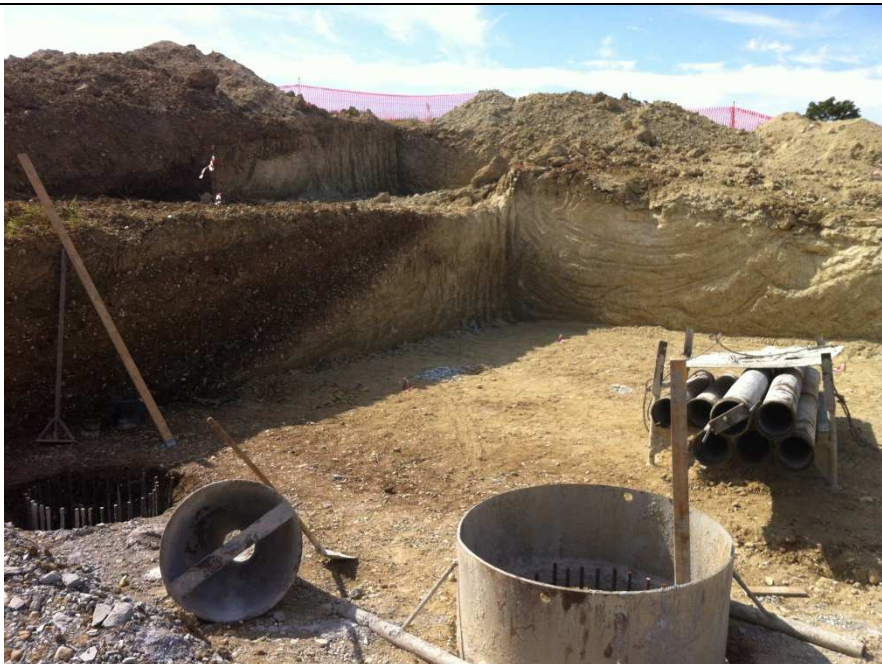
Figura 70: Macchina operatrice per la realizzazione di pali trivellati. Particolare del “carotiere”
