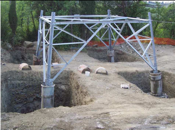
Figura 54: Realizzazione di fondazioni superficiali tipo CR per un sostegno a traliccio. Nell’immagine si possono osservare le quattro buche, la base del sostegno collegata alla fondazione tramite i “monconi” ed i casseri utilizzati per i quattro “colonnini”
