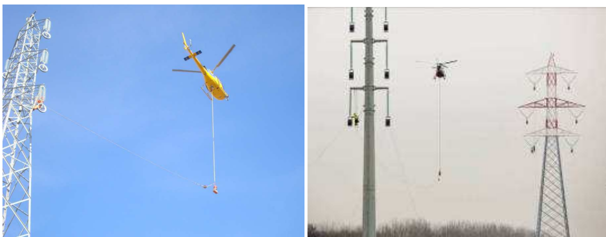
Figura 84: Utilizzo dell'elicottero per la stesura della fune pilota
