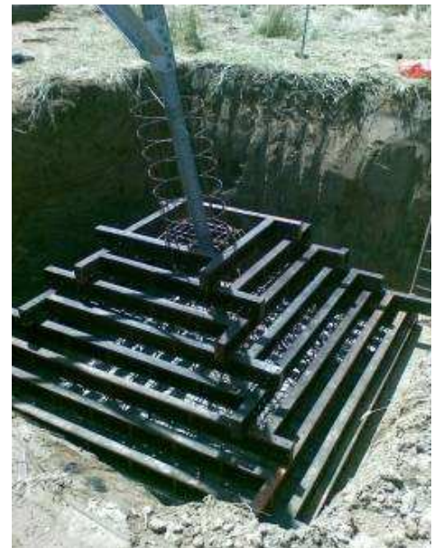
Figura 59: Esempio di realizzazione di una fondazione a plinto con riseghe. Nell'immagine di sinistra si può osservare un disegno di progetto mentre nell'immagine di destra la fase di cassatura della fondazione
