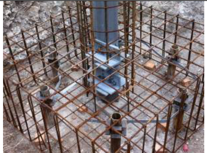
Figura 76: Esempio di realizzazione di una fondazione su micropali tipo tubfix. Nell'immagine di destra si può notare il particolare del raccordo tra i tubolari metallici dei micropali con l'armatura del plinto di fondazione; al centro del plinto si nota il moncone del sostegno (elemento di raccordo tra il sostegno e la fondazione) il quale viene annegato nella fondazione stessa
