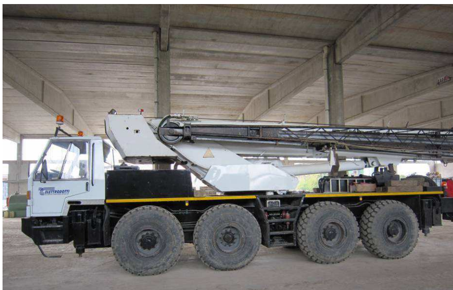
Figura 50: Area centrale – Mezzo utilizzato in fase di cantiere
