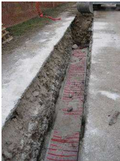
Figura 92: Rinterro con posa delle piastre di protezione e rete in PVC
