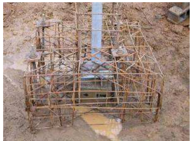
Figura 63: Esempio di fondazione con tiranti in roccia
