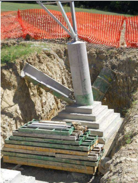
Figura 55: Realizzazione di fondazioni superficiali tipo CR per un sostegno a traliccio. Nell’immagine si può osservare una fondazione CR appena “scasserata”. Si possono distinguere facilmente la parte inferiore a parallelepipedi tronco piramidali ed il colonnino di raccordo con la “base” del sostegno
