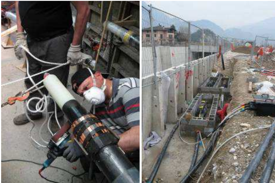
Figura 93: Esecuzione giunto esempio di buca giunti
