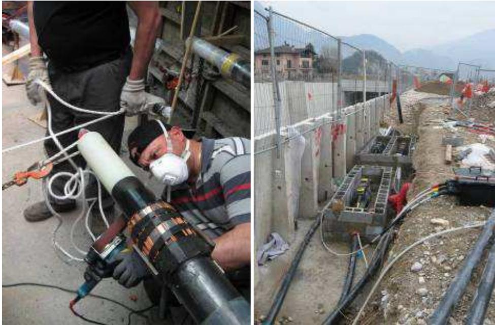
**Figura 33: Esecuzione giunto esempio di buca giunti**
