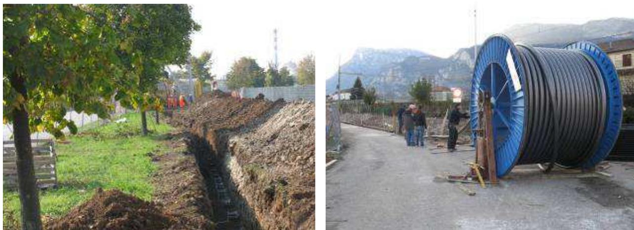
**Figura 32: Posa rulli lungo lo scavo e stendimento del cavo**
