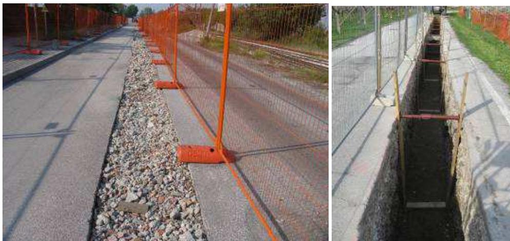
**Figura 31: Taglio dell'asfaltatura e scavo aperto**
