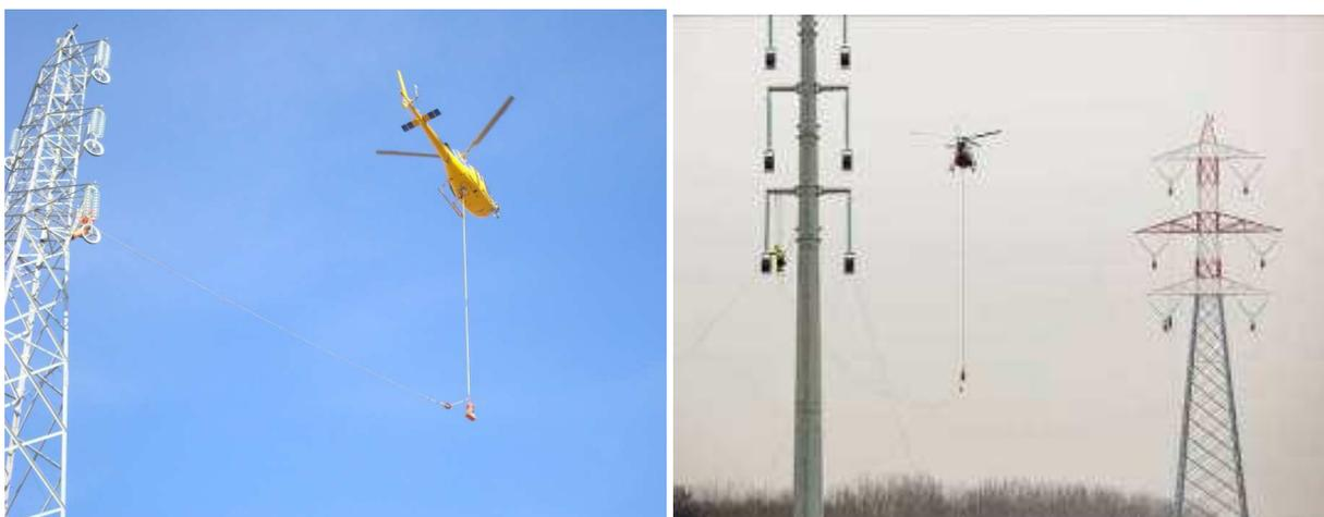
Figura 27: Utilizzo dell'elicottero per la stesura della fune pilota
