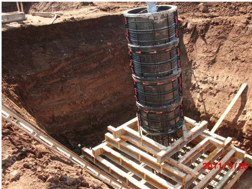
**Figura 9: Realizzazione di fondazioni superficiali tipo CR per un sostegno a traliccio. Nell'immagine si può osservare la fase di cassetatura**
