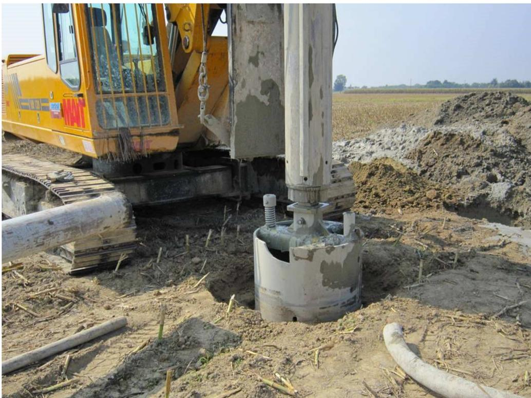
*Figura 19: Macchina operatrice per la realizzazione di pali trivellati. Particolare del “carotiere”*
