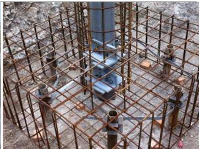
**Figura 25: Esempio di realizzazione di una fondazione su micropali tipo tubfix. Nell'immagine di destra si può notare il particolare del raccordo tra i tubolari metallici dei micropali con l'armatura del plinto di fondazione; al centro del plinto si nota il moncone del sostegno (elemento di raccordo tra il sostegno e la fondazione) il quale viene annegato nella fondazione stessa**
