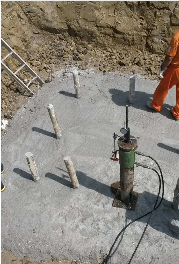
*Figura 29: Realizzazione di micropali tipo tubfix per un sostegno a traliccio; si possono osservare i 9 micropali già realizzati ed iniettati; in questa fase, prima dell'armatura e cassetatura del plinto di fondazione, si sta eseguendo una prova di tenuta del micropalo allo strappamento, al fine di verificare la corretta progettazione e realizzazione dello stesso*
