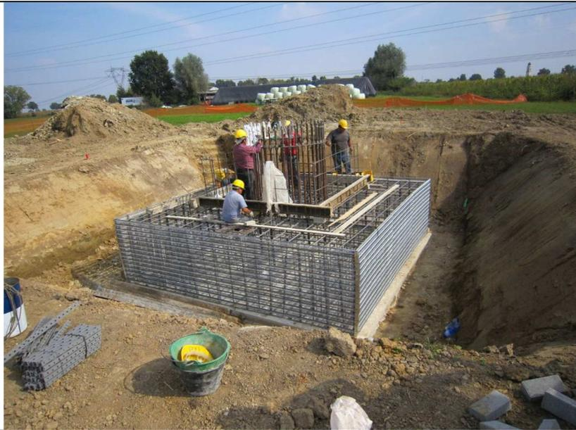
**Figura 14: Realizzazione di fondazione superficiale tipo plinto a monoblocco per un sostegno monostelo.**
