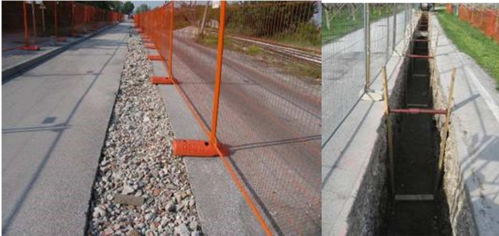
*Figura 35: Taglio dell'asfaltatura e scavo aperto*
