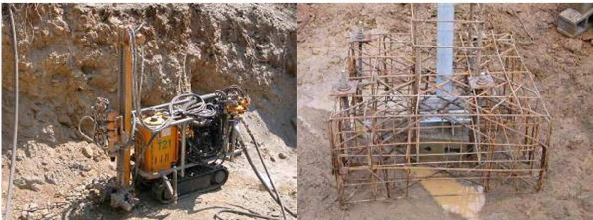
Figura 12: Esempio di fondazione con tiranti in roccia
