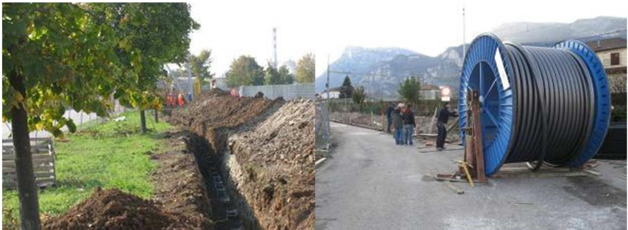
*Figura 36: Posa rulli lungo lo scavo e stendimento del cavo*
