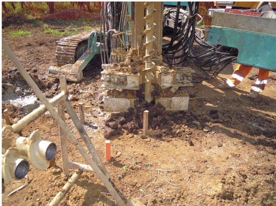
**Figura 27:** Macchina operatrice per la realizzazione di micropali tubfix; sistema di scavo mediante trivella elicoidale
