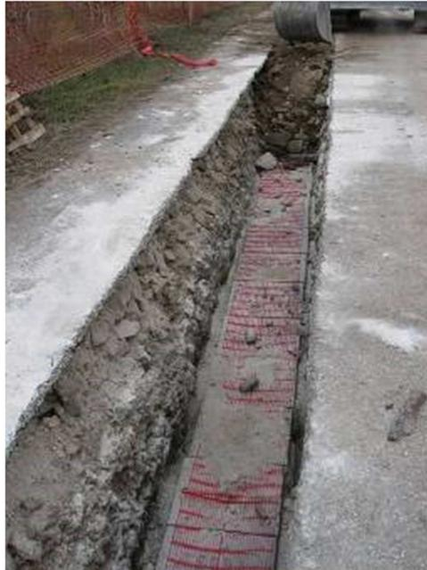
***Figura 37: Rinterro con posa delle piastre di protezione e rete in PVC***
