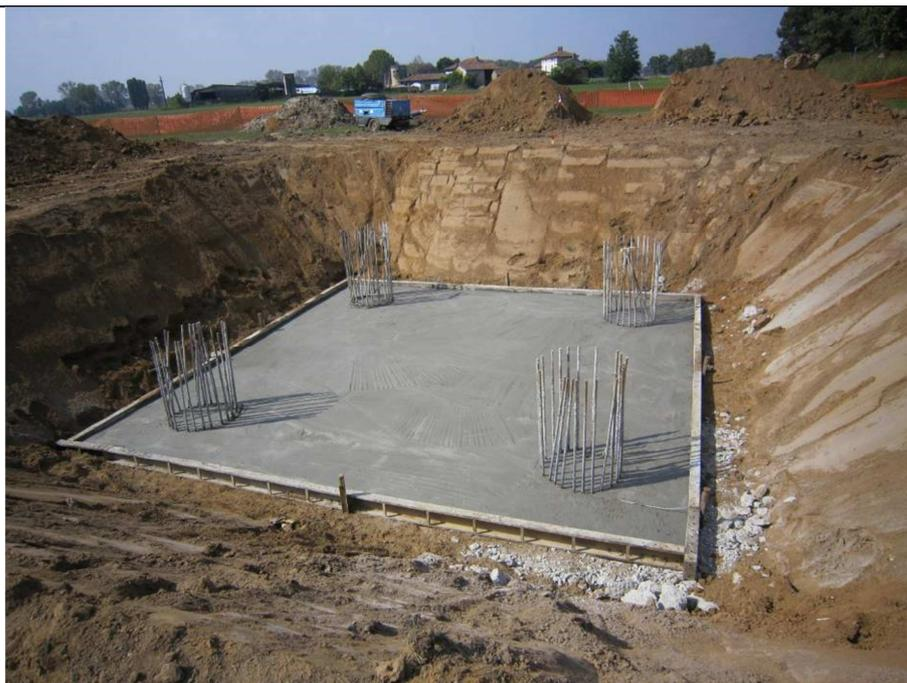
**Figura 21: Realizzazione di una fondazione su pali trivellati per un sostegno monostelo. Nell'immagine si può osservare una fondazione in fase di realizzazione. Si possono distinguere facilmente i quattro pali trivellati già realizzati e gettati (si osservano le "riprese" delle quattro gabbie metalliche) ed il piano di "magrone" sul quale impostare il monoblocco in cls**
