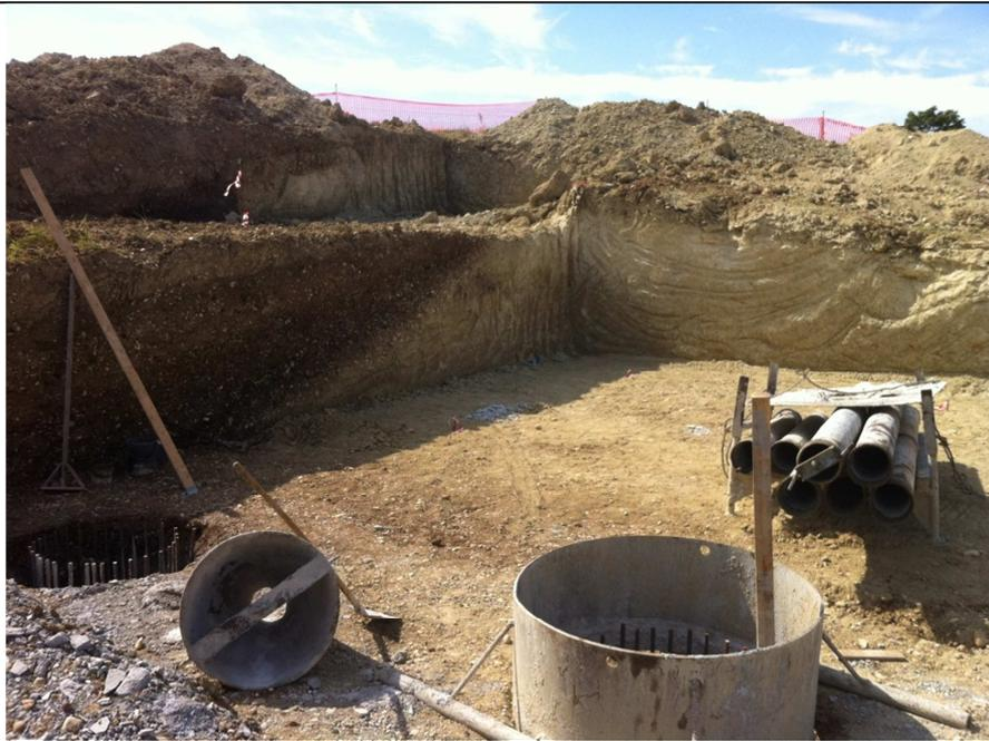
**Figura 20: Realizzazione di una fondazione su pali trivellati per un sostegno monostelo.**
