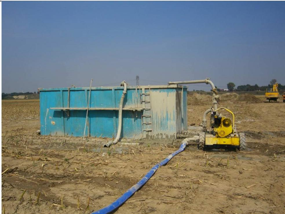
**Figura 24:** Allestimento di un impianto a circuito chiuso per la realizzazione di pali trivellati mediante l'utilizzo di fanghi bentonitici.
