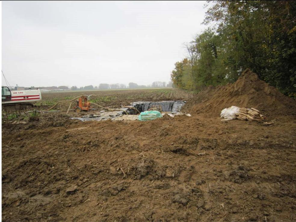
**Figura 23:** Allestimento di un impianto a circuito chiuso per la realizzazione di pali trivellati mediante l'utilizzo di fanghi bentonitici. In questa immagine si osservano la vasca impermeabilizzata per la decantazione del fango, la pompa di rilancio del fango verso il foro e l'area di deposito dei sacchi contenenti la bentonite
