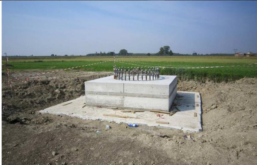
**Figura 15: Realizzazione di fondazioni superficiali tipo plinto a monoblocco per un sostegno monostelo.**
