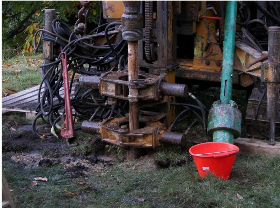
**Figura 26:** Macchina operatrice per la realizzazione di micropali tubfix; sistema di scavo a rotopercussione
