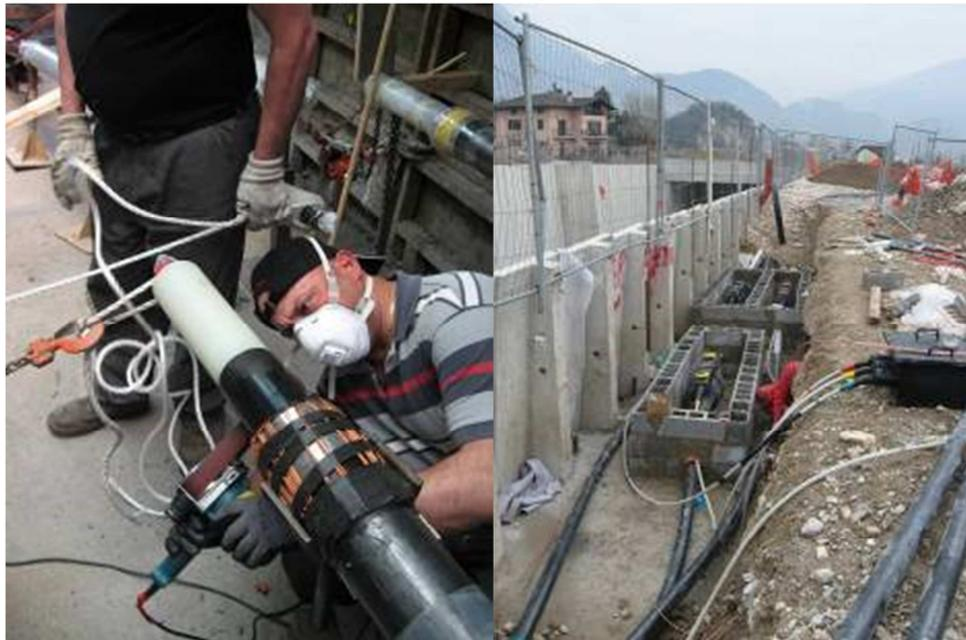
Figura 38: Esecuzione giunto esempio di buca giunti
