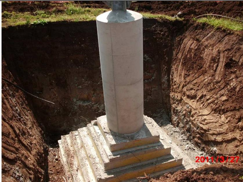
**Figura 10: Realizzazione di fondazioni superficiali tipo CR per un sostegno a traliccio.** Nell'immagine si può osservare una fondazione CR appena "scasserata". Si possono distinguere facilmente la parte inferiore a parallelepipedo tronco piramidali ed il colonnino di raccordo con la "base" del sostegno
