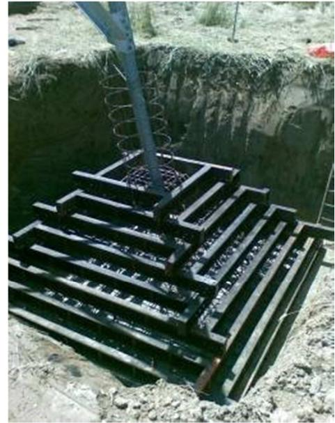
**Figura 8: Esempio di realizzazione di una fondazione a plinto con riseghe. Nell'immagine di sinistra di può osservare un disegno di progetto mentre nell'immagine di destra la fase di cassetatura della fondazione**
