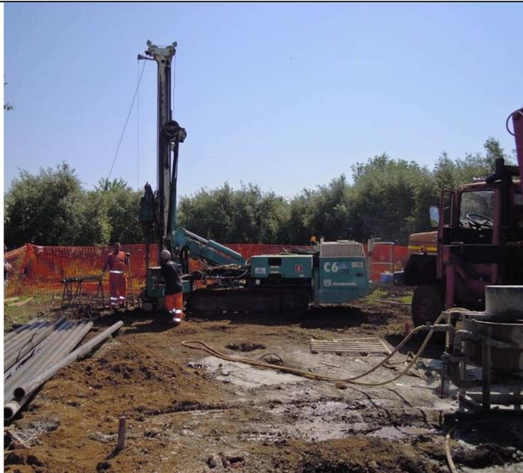
*Figura 28: Cantiere per la realizzazione di micropali tipo tubfix; si può osservare sulla sinistra la zona di deposito dei tubolari metallici i quali costituiranno l'armatura dei micropali e sulla destra il miscelatore per la preparazione della boiaccia di cemento per l'iniezione a gravità dei micropali*
