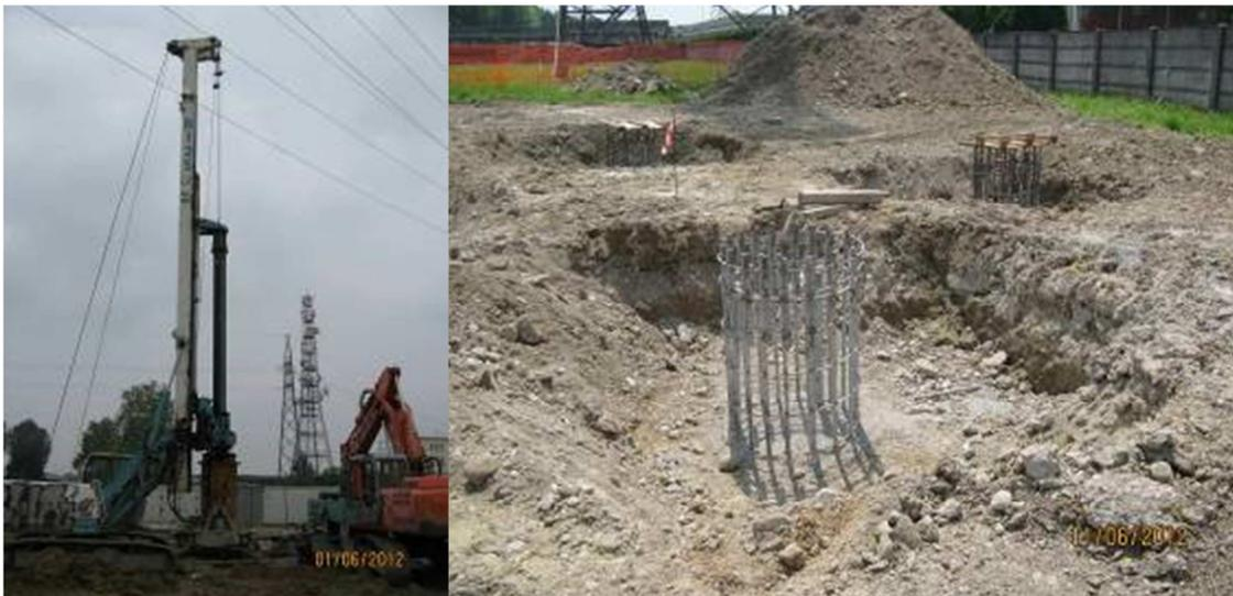
Figura 17: Esempio di realizzazione di una fondazione su pali trivellati.
