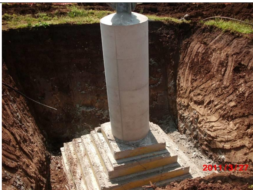
Realizzazione di fondazioni superficiali tipo CR per un sostegno a traliccio. Nell'immagine si può osservare una fondazione CR appena "scasserata". Si possono distinguere facilmente la parte inferiore a parallelepipedi tronco piramidali ed il colonnino di raccordo con la "base" del sostegno
