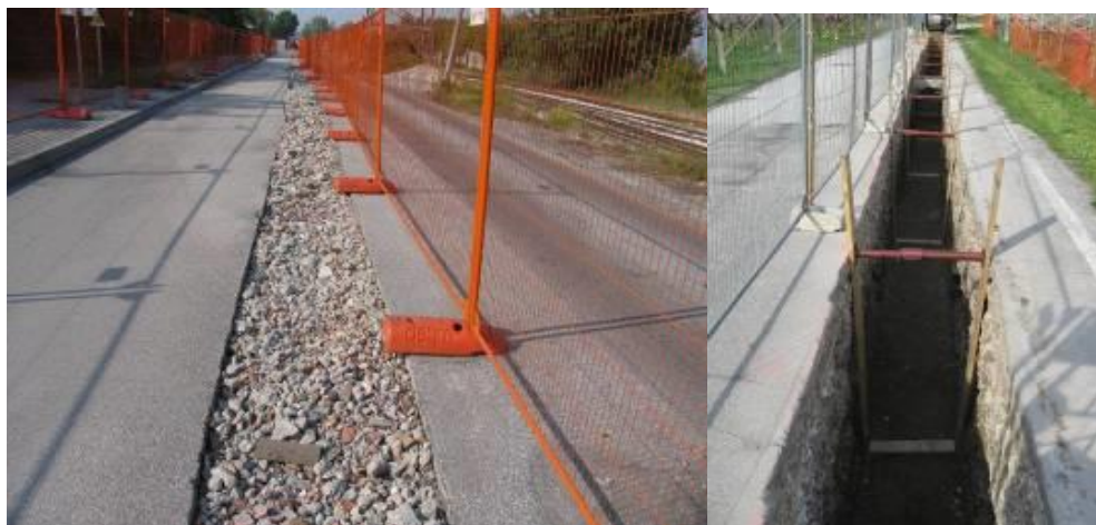
Taglio dell'asfaltatura e scavo aperto
