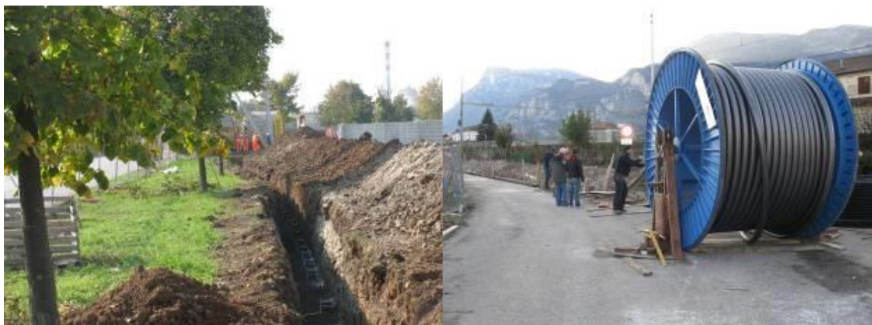
Posa rulli lungo lo scavo e stendimento del cavo
