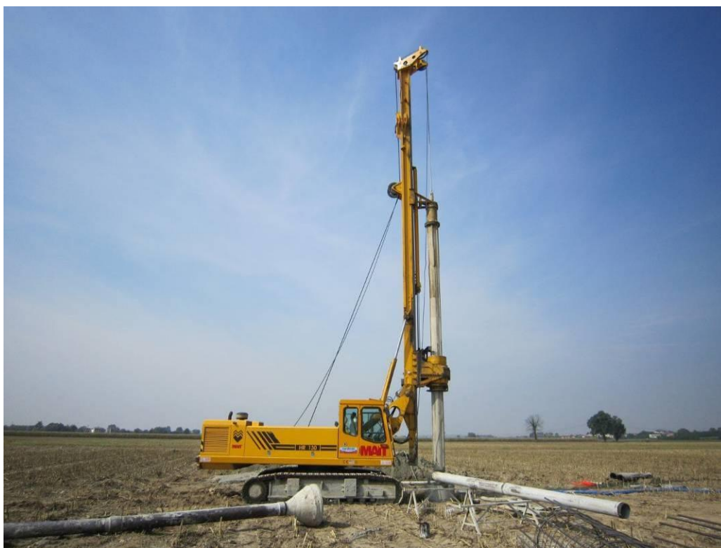
Macchina operatrice per la realizzazione di pali trivellati
