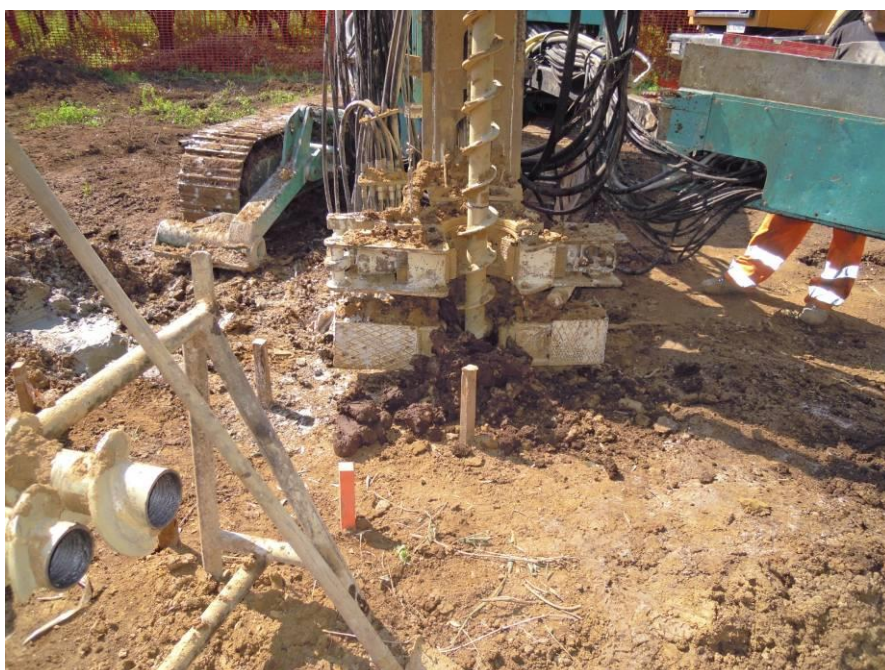
Macchina operatrice per la realizzazione di micropali tubfix; sistema di scavo mediante trivella elicoidale
