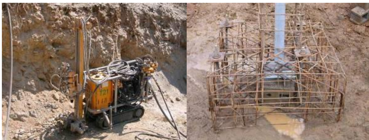
Esempio di fondazione con tiranti in roccia
