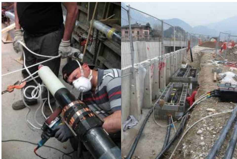
Esecuzione giunto ed esempio di buca giunti
