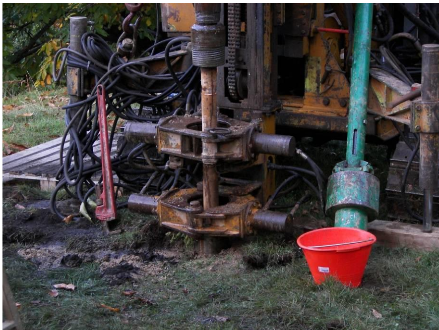
Macchina operatrice per la realizzazione di micropali tubfix; sistema di scavo a rotopercussione
