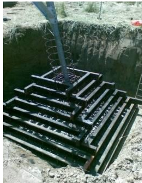
Esempio di realizzazione di una fondazione a plinto con riseghe. Nell'immagine di sinistra di può osservare un disegno di progetto mentre nell'immagine di destra la fase di cassetatura della fondazione
