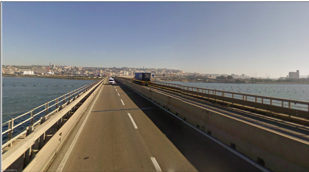
Figura 3-4 SS 195 Viabilità collegamento porto canale con il porto vecchio (punto 1 mappa Figura 3-3).
