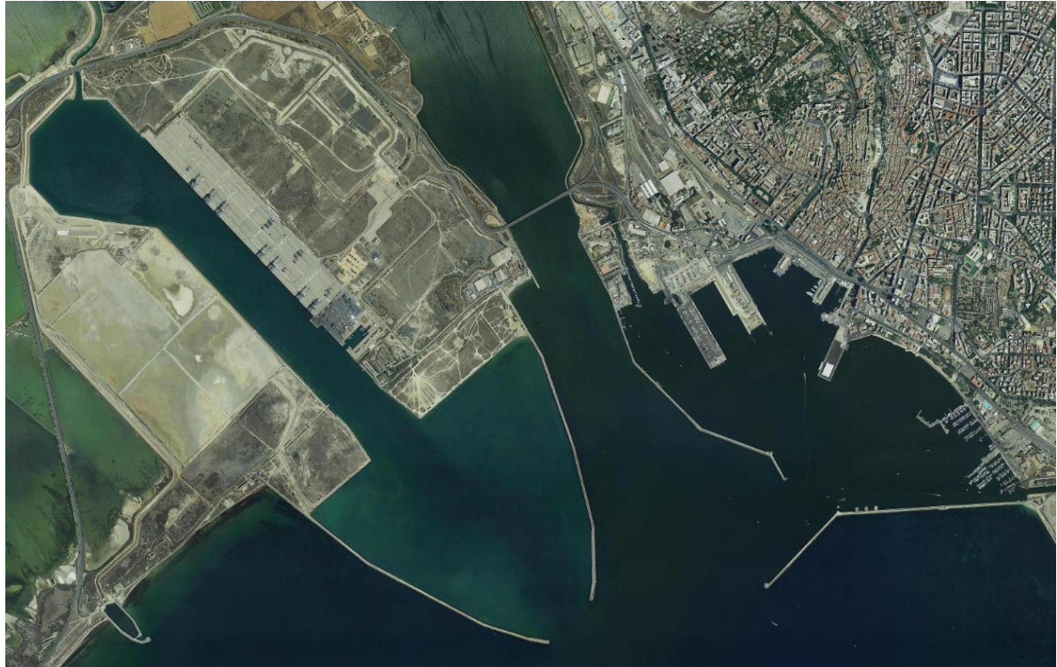
Figura 2-4Foto aerea del bacino portuale di Cagliari 1
