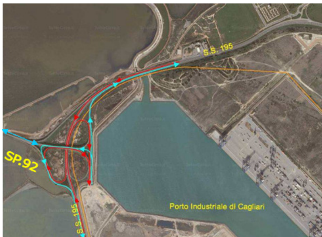
Figura 4-8 - Svincolo fra la S.S. 195 e la S.P. 92.
