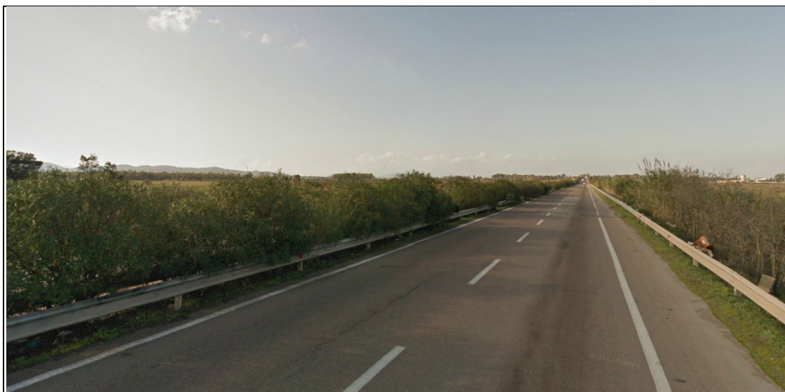
Figura 3-14: strada con carreggiate separate 2 corsie per senso di marcia con banchina - punto 3 di mappa della Figura 3-10.
