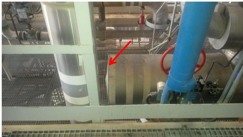
Figura 6 - collettore esistente vapore bassa pressione 24"
