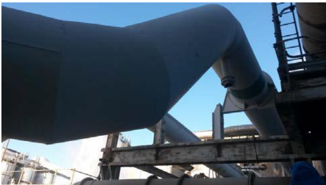
Figura 8 – Passaggi della nuova tubazione BP
