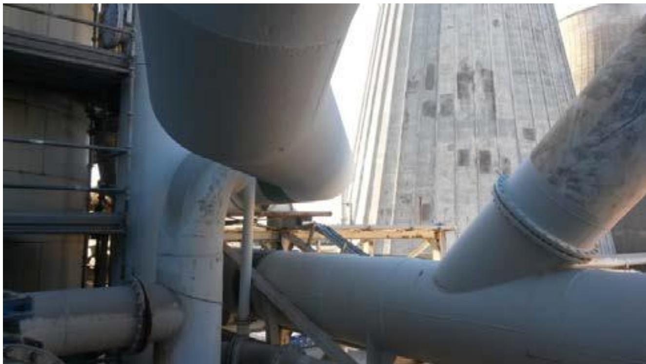
Figura 7 – Passaggi della nuova tubazione BP
