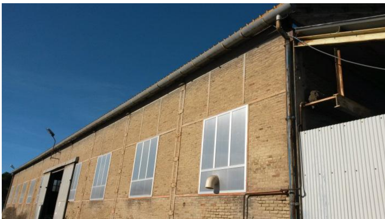
Figura 6 – Passaggi della nuova tubazione BP
