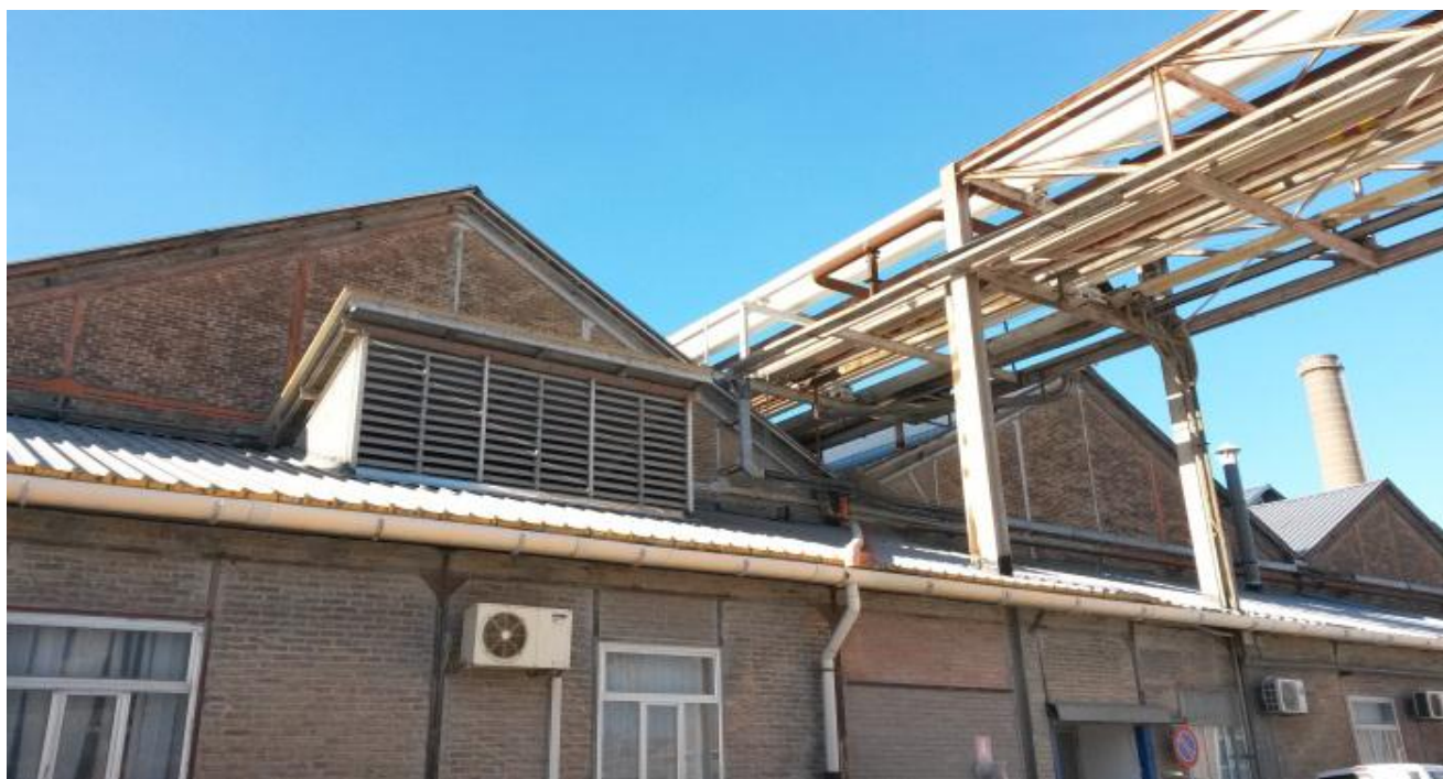
Figura 5 – Passaggi della nuova tubazione BP
