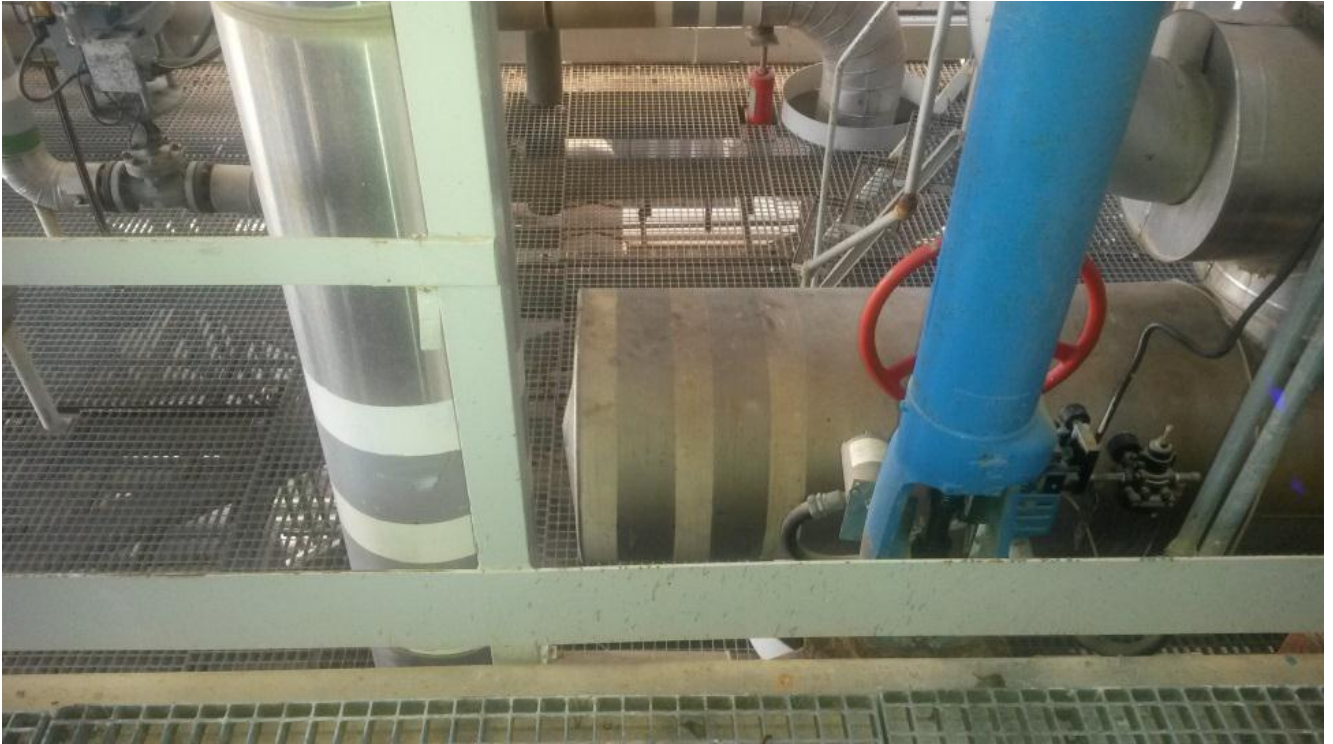
Figura 4 – collettore esistente vapore bassa pressione 24”
