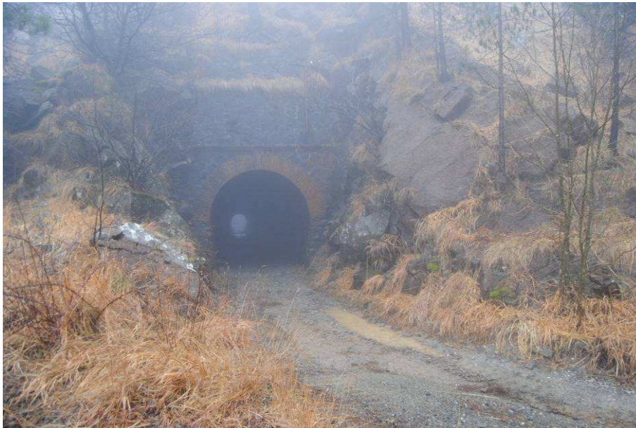
Figura 19 Ingresso al tunnel e a sinistra inizio della strada alternativa
