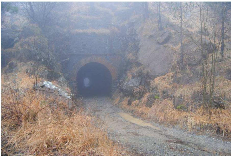
Figura 5 Strada di accesso alla diga e vecchia galleria scavata per accedere all'area, durante i lavori di costruzione della diga di Badana (XIX secolo)
