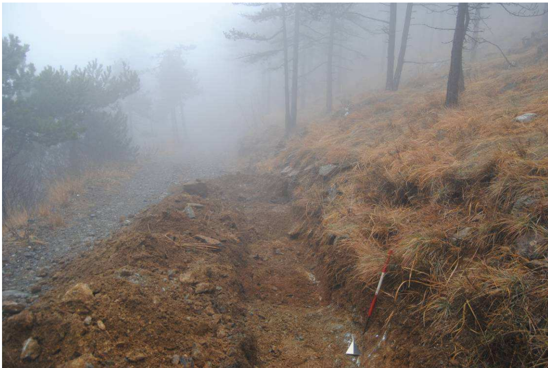
Figura 15 Saggio F. Ubicazione della trincea ai bordi della strada, lato monte
