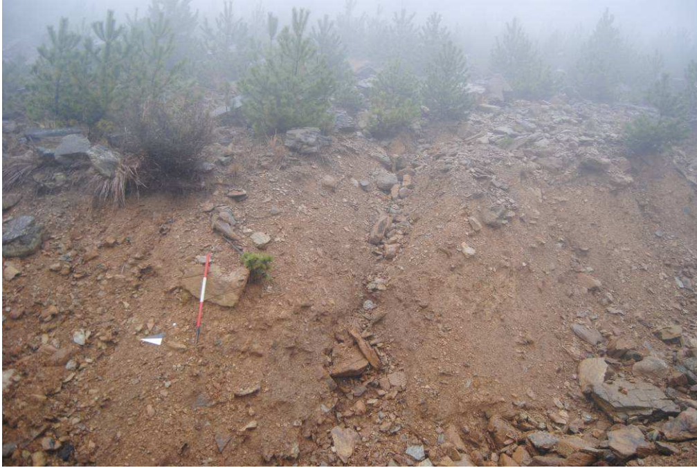
Figura 11 B Esiguo strato di humus(sottobosco) superficiale e spessa coltre di terreno colluviale con presenza di solchi di erosione
