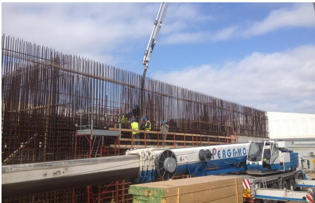
Figura 3.1/3 – Foto di cantiere durante il getto delle strutture in elevazione
