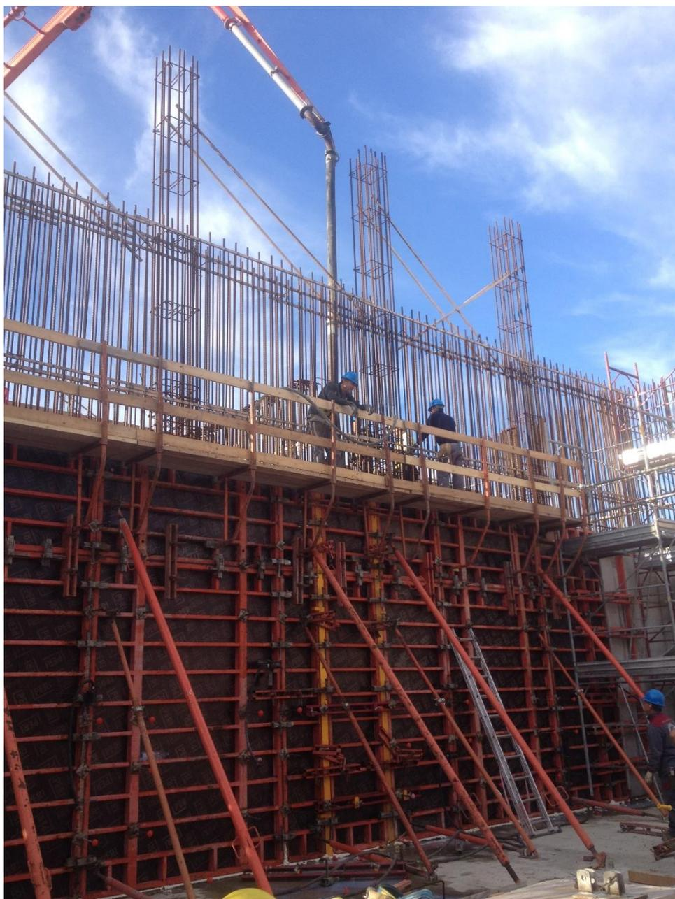
Figura 3.1/2 – Foto di cantiere durante il getto delle strutture in elevazione
