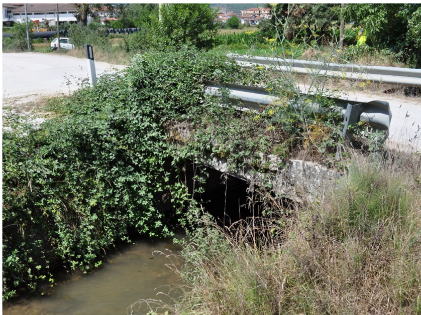
Figura 9 - Ponte della SP 377 sul Torrente Pantanelle (vista da monte).
