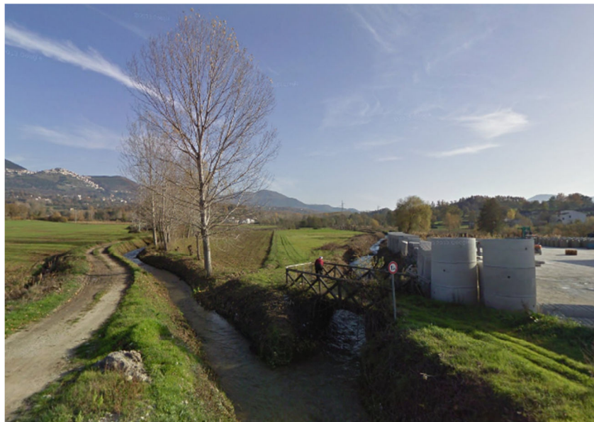
Figura 10 - Confluenza dei due corsi d'acqua oggetto di studio, a destra il Torrente Pantanelle con un attraversamento in legno, a sinistra il Canale Imperatore (vista da valle tratta da Google Earth, risalente al 2009)
