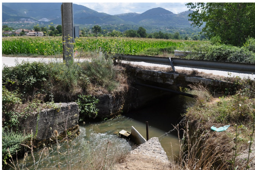
Figura 11 - Ponte della SP 377 (vista da valle) e manufatto partitore.
