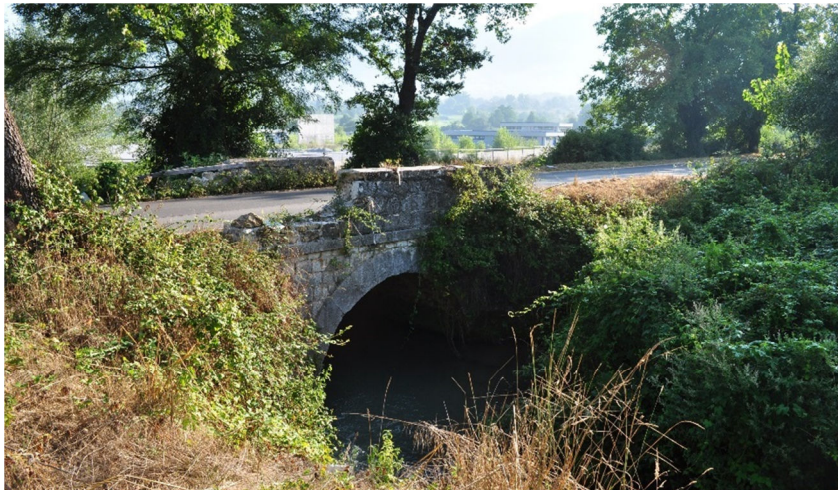
Figura 8 - Ponte di Via S. Pietro sul Torrente Pantanelle (vista da monte).
