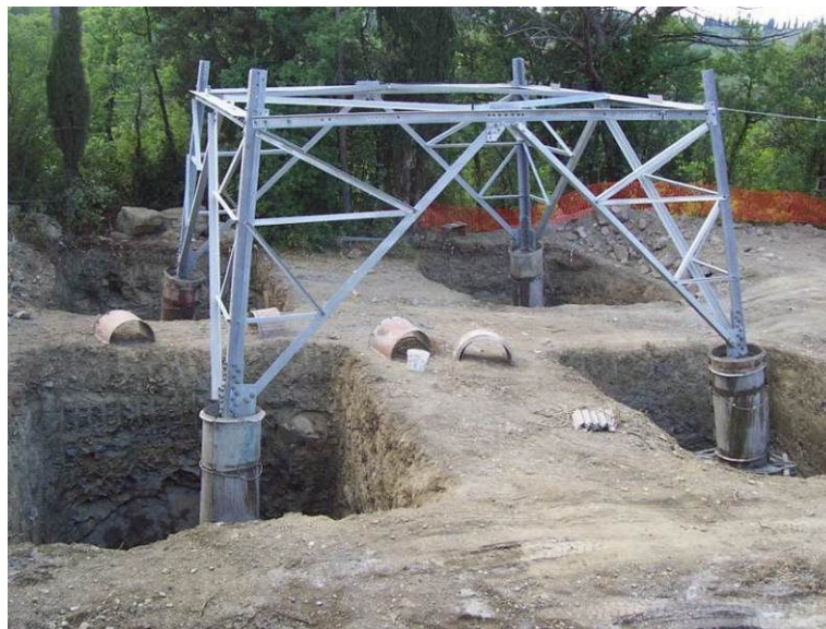
Figura 10.1 - Esempio di fondazione di un sostegno
