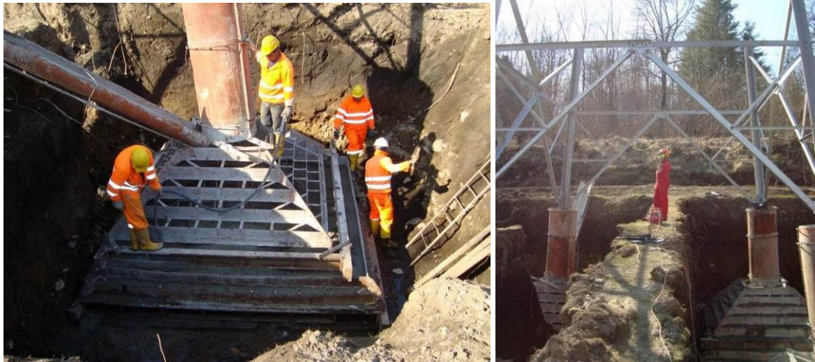
Figura 10.2 - Esempio di realizzazione del piede di fondazione
