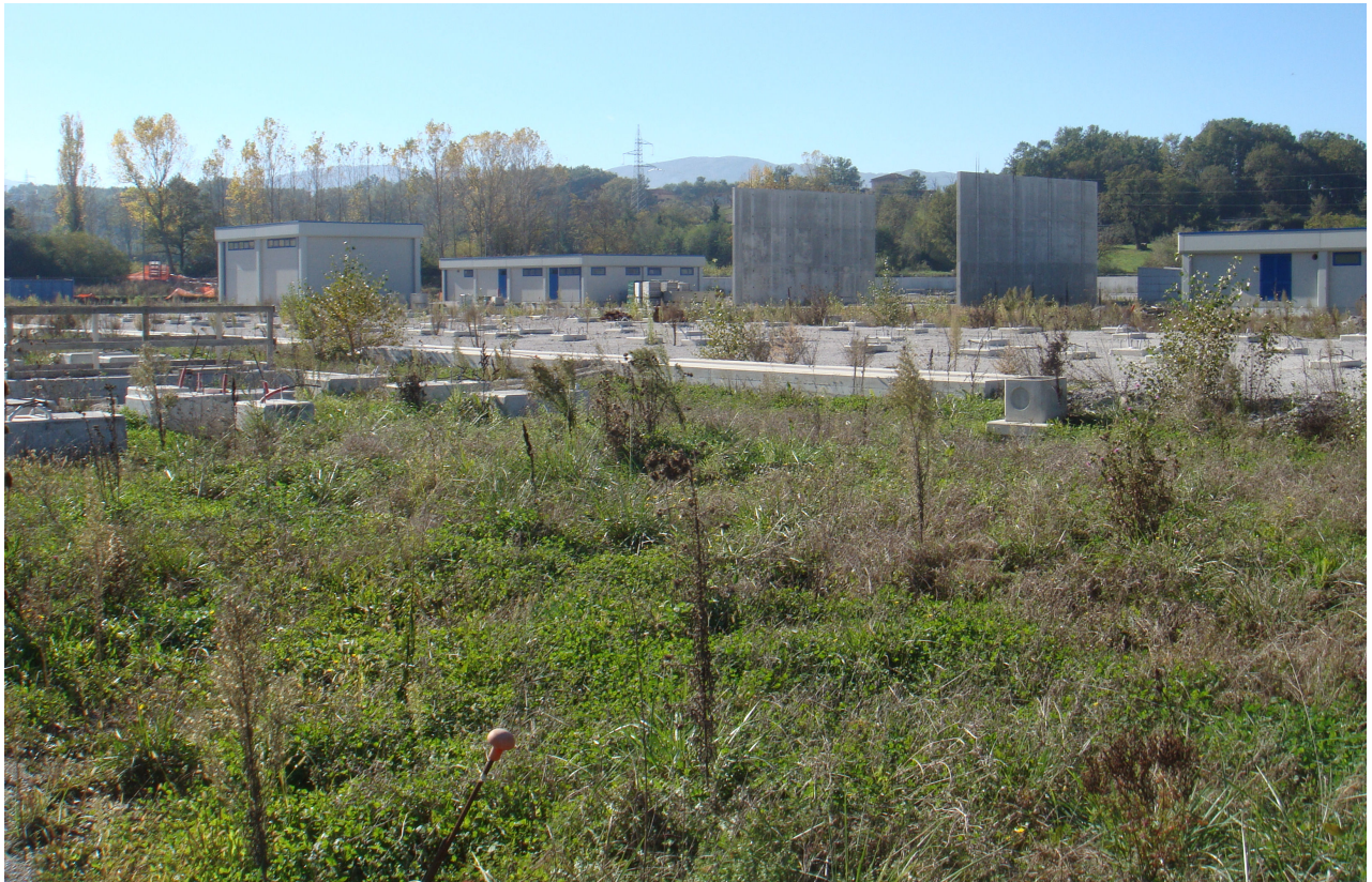
Figura 20 – Area di ubicazione della stazione elettrica 220/150 kV di Montesano
