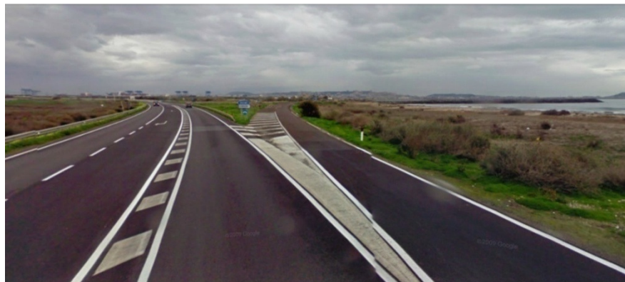
Figura 5-9 - Inneso della ex SS195 lungo la nuova SS195.
