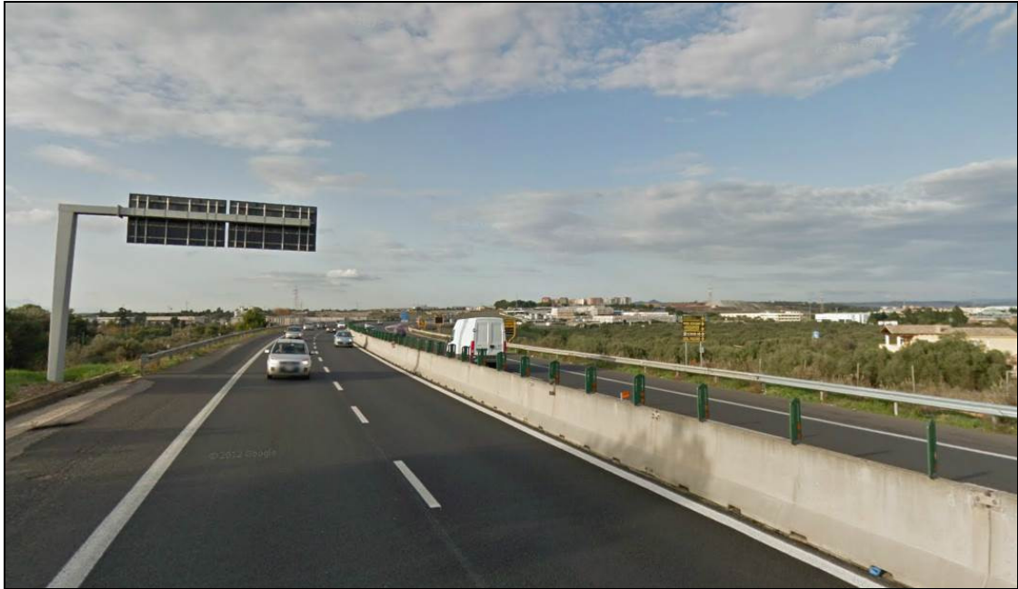
Figura 3-6 SS 131 Viabilità di accesso all'area portuale da nord (punto 3 mappa Figura 3-3)
