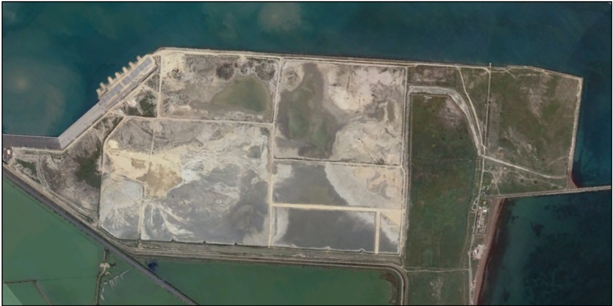
Figura 6-1 – Casse di colmata esistenti
