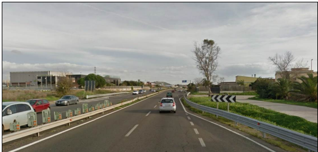
Figura 3-5 SS 130 Viabilità di accesso all'area portuale da nord (punto 2 mappa Figura 3-3)
