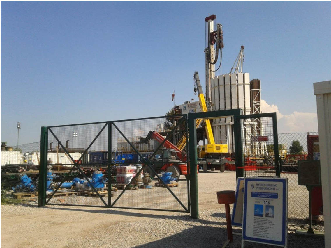
Figura 3-10. Cancelli di entrata alla piazzola di perforazione.
