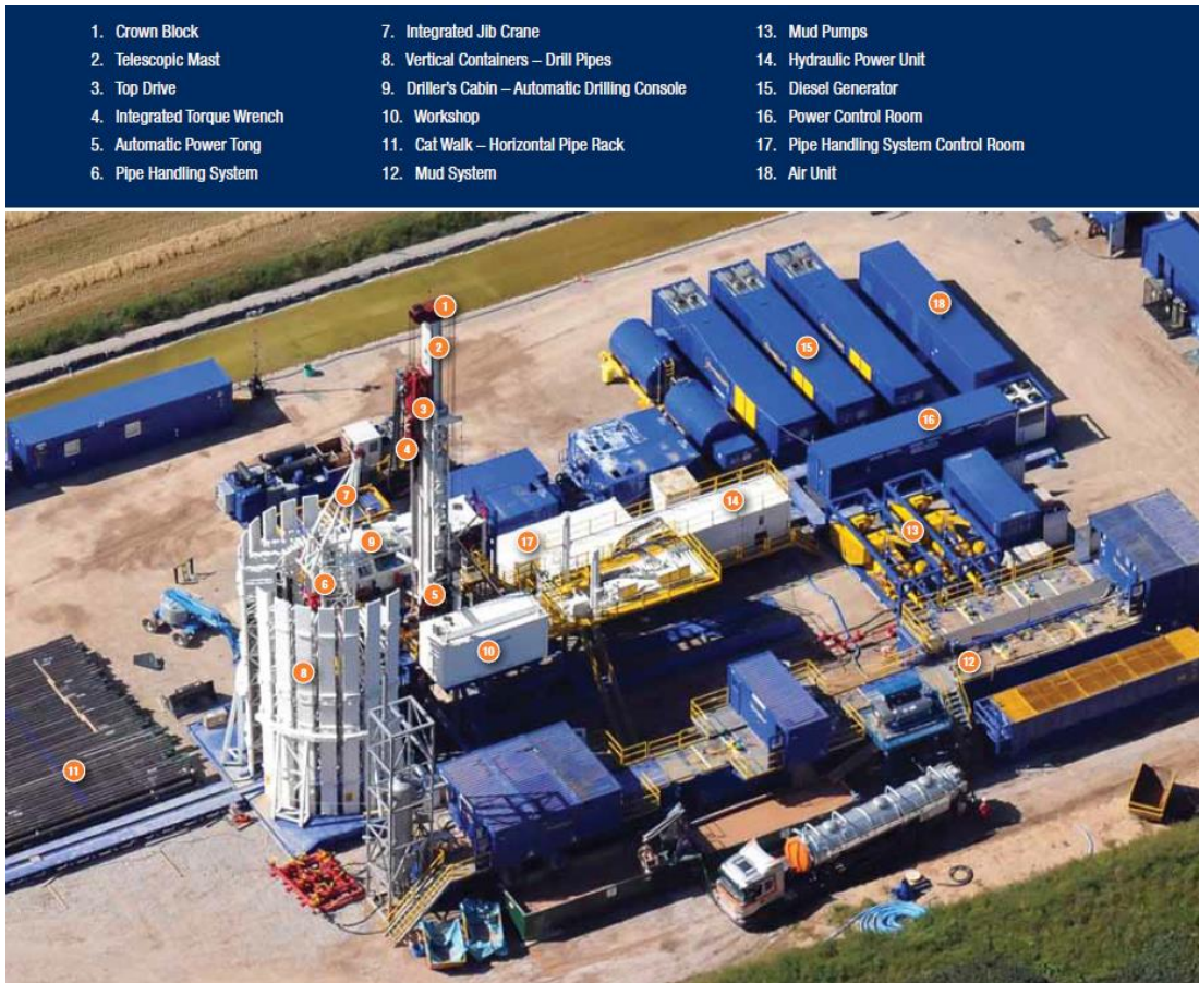
Figura 3-14. Esempio di impianto Drillemec serie HH.
