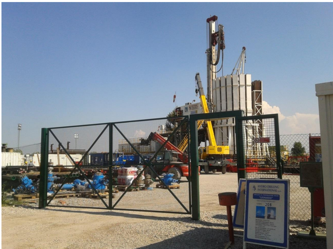
Figura 3-7. Cannello di entrata alla piazzola di perforazione.
