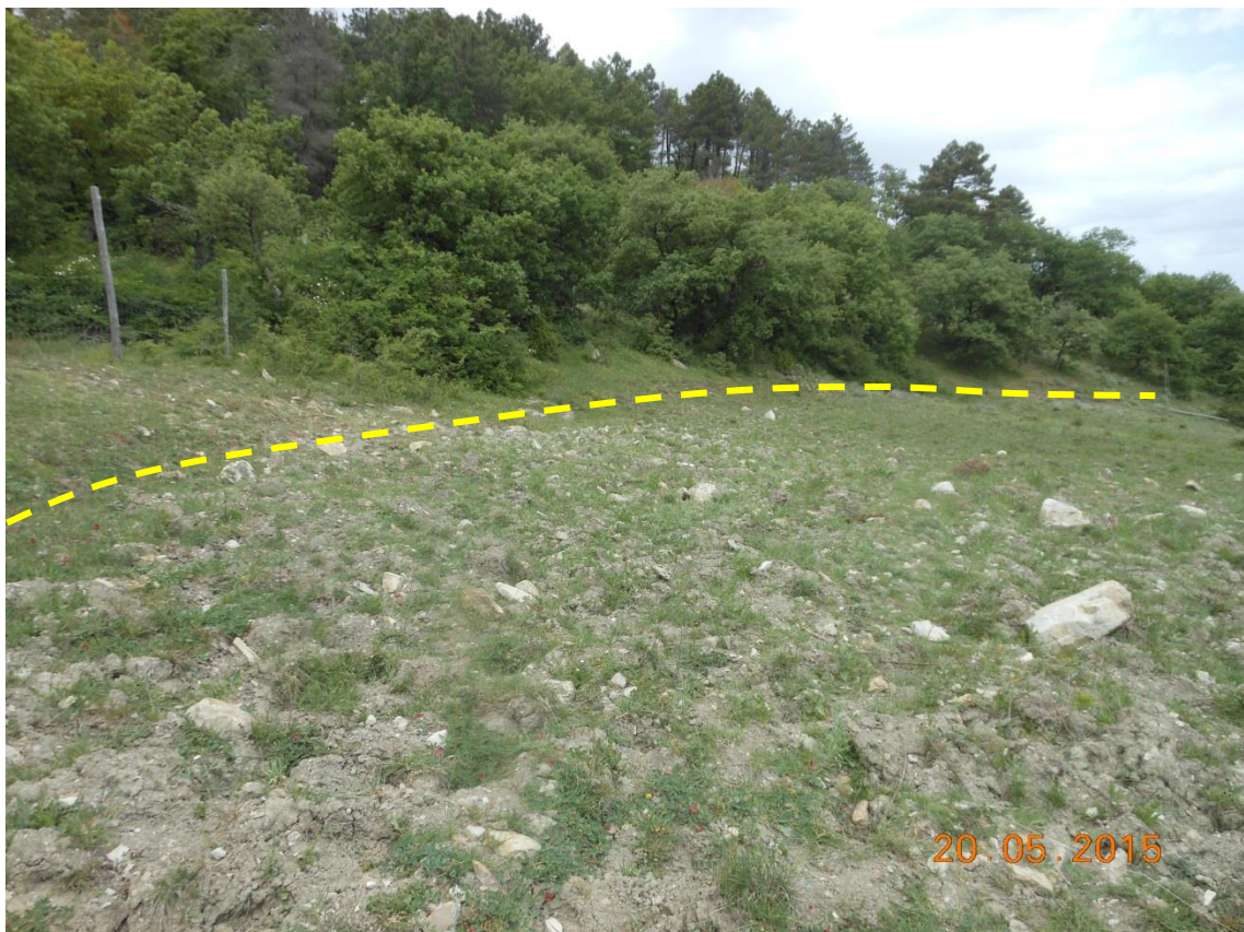
Figura 8-3. Scarpata morfologica legata al coronamento del corpo di frana.
