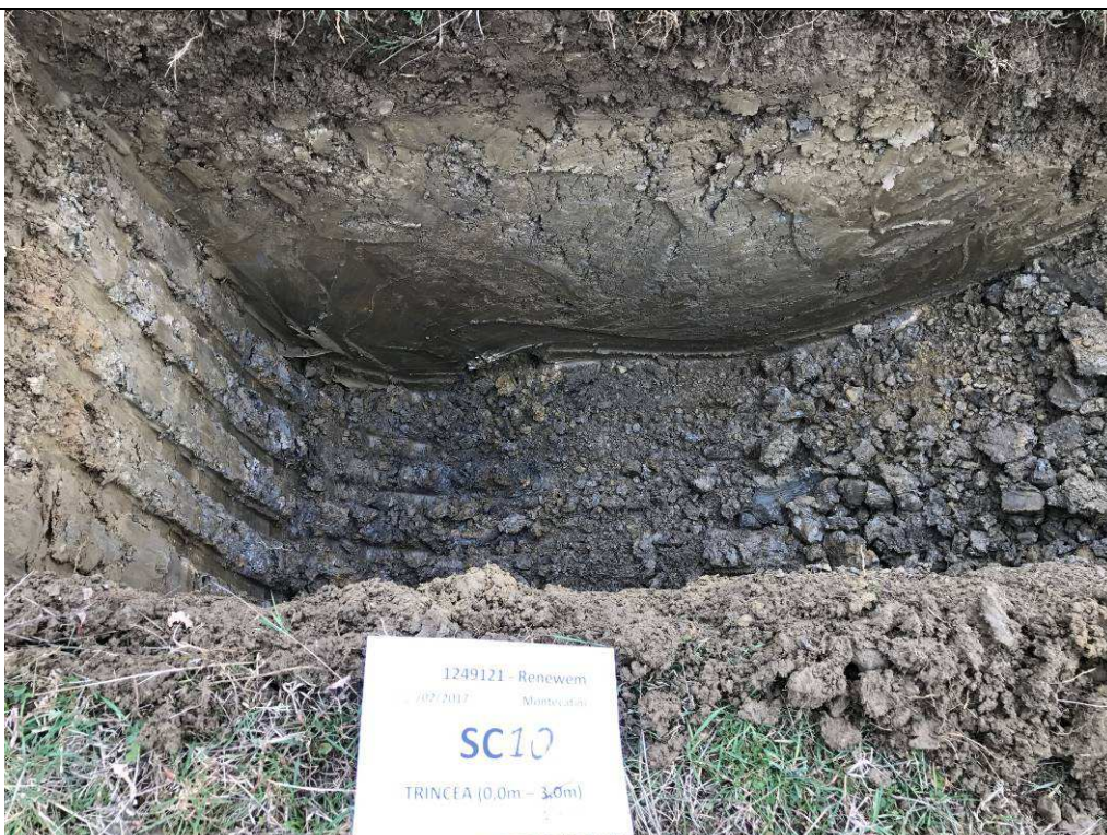
SC10 – Trincea (0,0-1,0) m p.c.
