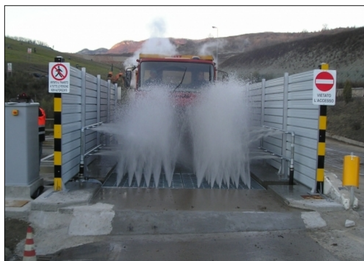
Figura D-1 Impianto di lavaggio dei mezzi di cantiere
