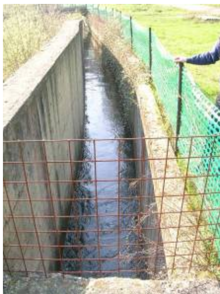
Figura 2.2.20 – Fotografia del canale di derivazione posto a lato dell’opera di presa.
