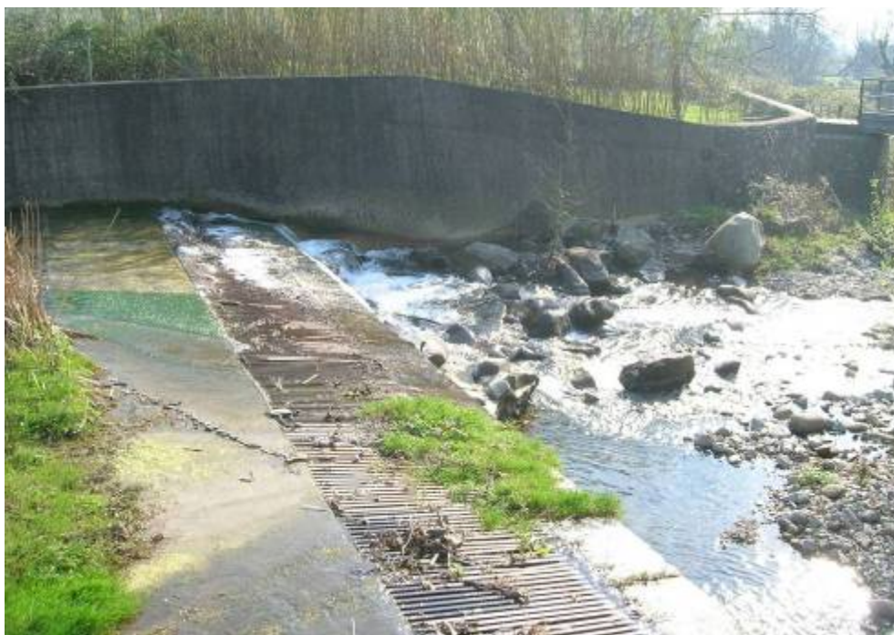
Figura 2.2.19 – Fotografia dell’opera di presa sul Torrente Vincio di Brandeglio.
