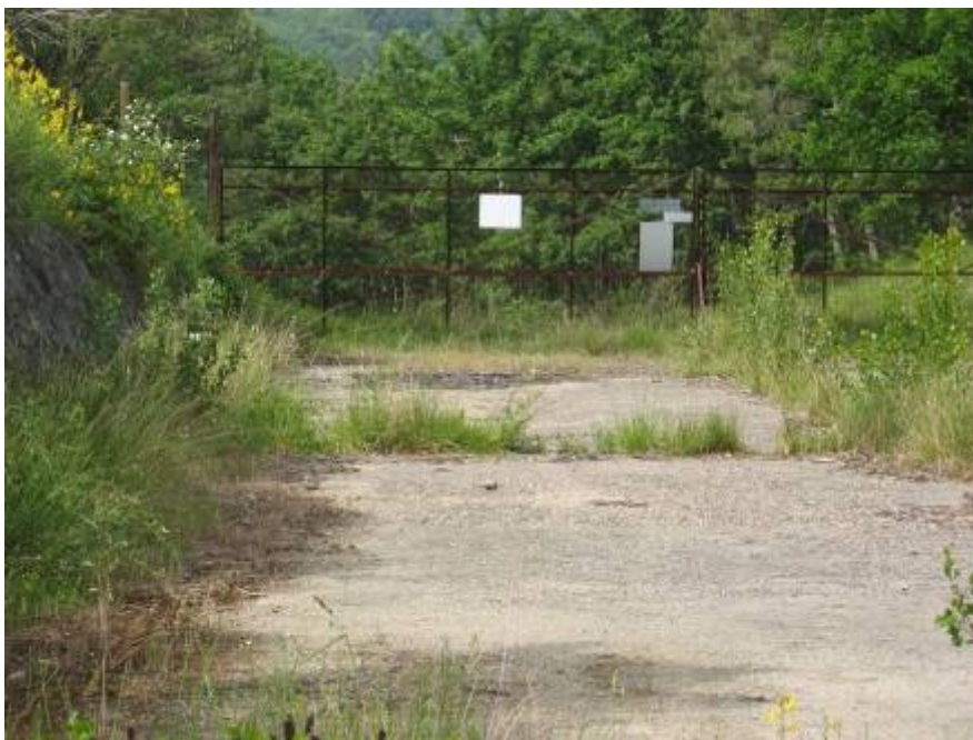
Figura 2.2.22 Scarico di superficie attuale.
