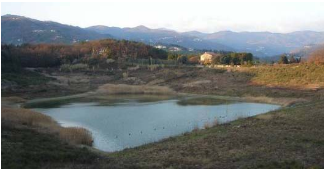
Figura 2.2.21 – Stato attuale dell’Invaso della Giudea in località Gello (PT).
