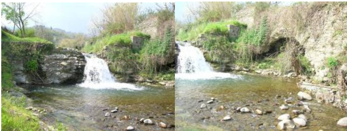
Figura 2.2.14 – Fotografie dello scavo e dell’instabilità laterale di sponda al piede della briglia a valle di ponte Agnolo.
