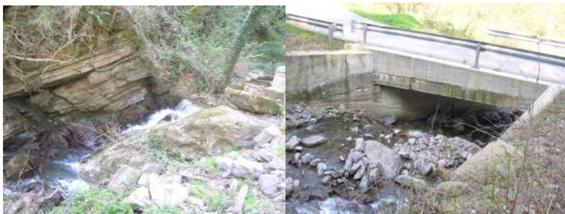
Figura 2.2.10 – Fotografie di sezioni del tratto montano del Torrente Vincio di Brandeglio.
