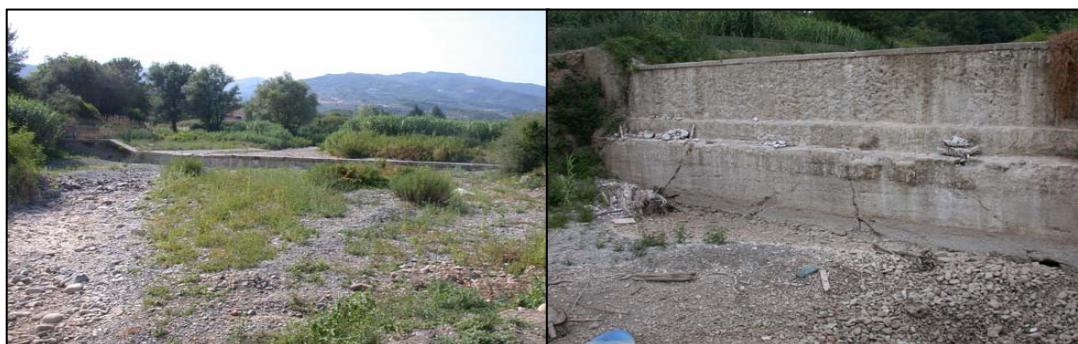
Figura 4.34 – Alvei asciutti e briglie insuperabili per la fauna ittica nei tratti 4 e 3
