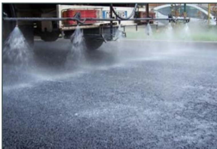
Figura 1-52 Esempio di tecnica applicativa del trattamento catalitico antismog
