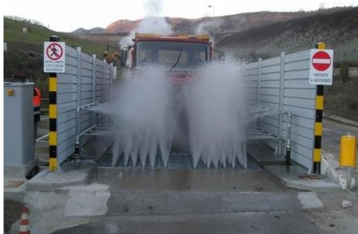
**Figura 4.1 - - impianto per il lavaggio delle ruote**
