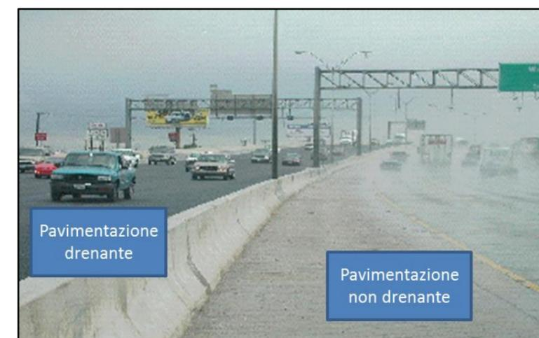
**Figura 2-95 Esempio di effetto spray su due pavimentazioni**
