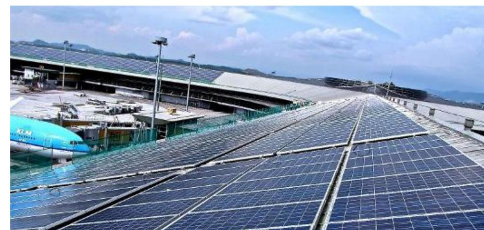
Figura 2-8 - Esempio di tecnologia fotovoltaica applicata a terminal aeroportuali
