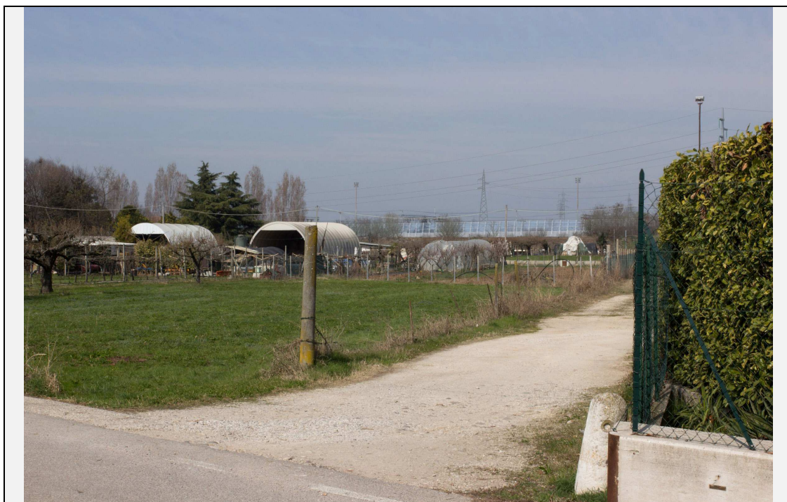
Figura 1-5 Visuale libera grazie alla soppressione del tratto di elettrodotto Peri e del sostegno sul lato nord-est della Villa Fenilon. Allontanandosi dall'intervento, l'elemento della barriera antirumore risulta poco visibile; l'adozione di pannelli fonoassorbenti in vetro creano un continuum visivo con lo sfondo.
