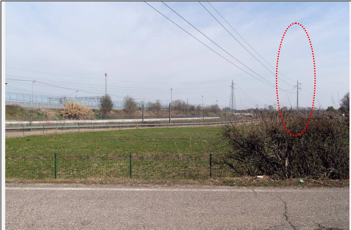
Figura 1-9 Fotoinserimento del progetto con barriere antirumore in materiale trasparente: la visuale da via Fenilon, nel tratto nord della villa. Nel cerchio si evidenzia il nuovo sostegno (n.410).
