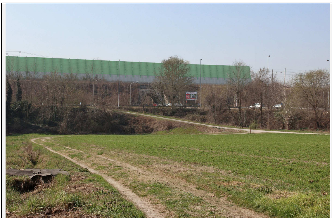
Figura 2-6 Visuale da Via Albere – post operam
