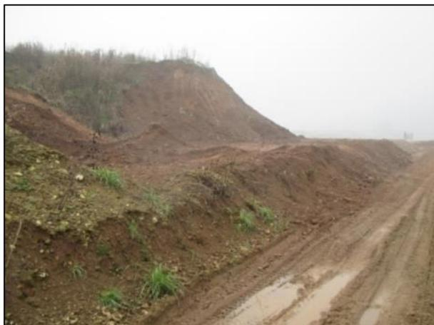
**Note:** Lungo la duna è stata rilevata l'assenza di materiale per circa 50 m di lunghezza, riutilizzato lungo la linea. Duna non sfalciata.
