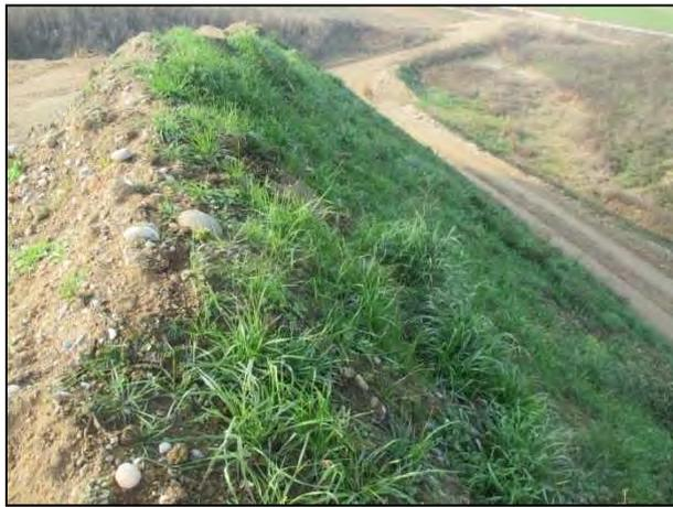
**Note:** Duna non sfalciata composta da terreno vegetale frammisto con materiale di pezzatura grossolana. Rilevata l'assenza di materiale per circa 10 m.
